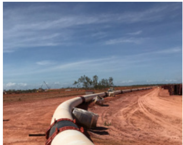
Figura 3. Instalación en curvas de acoples Victaulic ISO Estilo 908 de 900 mm.
