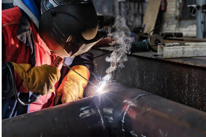
In manchen Fällen – gewöhnlich bei Edelstahlrohren – ist für das Schweißverfahren auch eine Vorbereitung der Oberfläche nötig, für die Lösungsmittel und Salpeter- und Fluorwasserstoffsäure verwendet werden, um das Rohr abzuweizen und zu passivieren und durch Schweißhitze getönte Schichten zu entfernen. Für diese Verfahren ist auch die ordnungsgemäße Entsorgung von Lösungsmittelabfällen, lösungsmittelgetränkten Lappen oder Werkzeugen sowie von Schmutzwasser in Abfallbehältern erforderlich.
