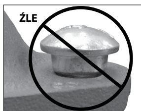
NIEPRAWIDŁOWO OSADZONA OWALNA SZYJKA ŚRUBY
