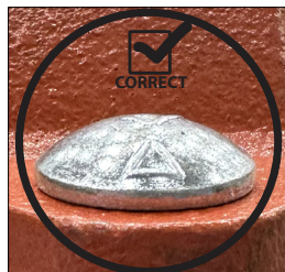
COLLET OBLONG DU BOULON MIS EN PLACE CORRECTEMENT
