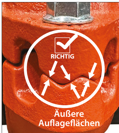
RICHTIG MONTIERTE VERBINDUNG – KONTAKT VON METALL AUF METALL WIE GEZEIGT AN ALLEN ÄUSSEREN AUFLAGEFLÄCHEN
