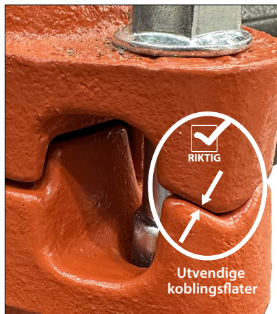
RIKTIG MONTERT SKJØT – METALLKONTAKT SOM INDIKERT PÅ ALLE UTVENDIGE KOBLINGSFLATER
