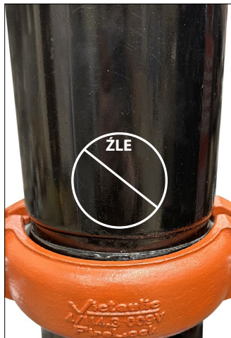
ZDJĘCIE 3 (NIEPRAWIDŁOWO) – WPUSTY RURY NIE ZOSTAŁY WYRÓWNANE Z JEJ ROWKAMI
