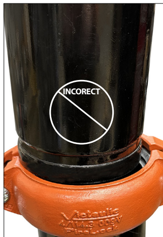
IMAGINEA 2 (NECORESPUNZĂTOR) – ȚEAVA S-A DESPRINS DE CUPLAJ
