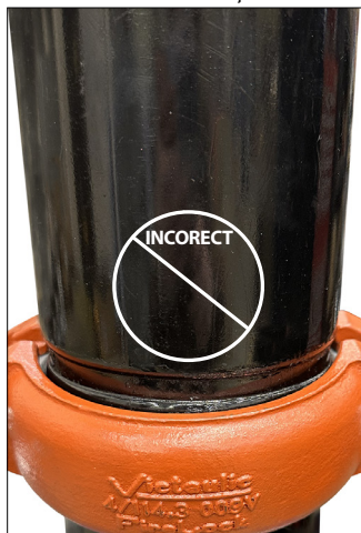
IMAGINEA 3 (NECORESPUNZĂTOR) – PENELE SEMICUPELOR NU SUNT ALINIATE CU CANELURILE ȚEVII
