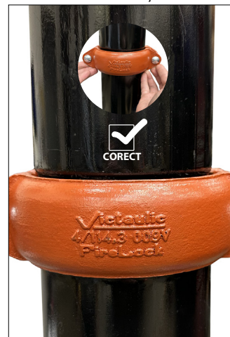
IMAGINEA 4 (CORESPUNZĂTOR) – PENELE SEMICUPELOR SUNT ALINIATE CU CANELURILE ȚEVII
