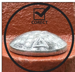
GĂTUL OVAL AL ȘURUBULUI AȘEZAT CORESPUNZĂTOR
