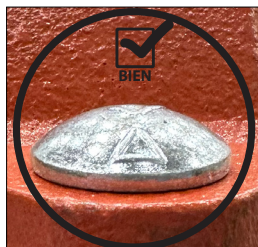
CUELLO OVAL DEL PERNO ASENTADO CORRECTAMENTE
