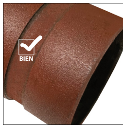
BIEN EL EXTREMO DE LA TUBERÍA NO TIENE PINTURA DAÑADA EN LA DIMENSIÓN "A"
