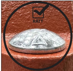
DEN OVALA HALSEN PÅ BULTEN SITTER KORREKT
