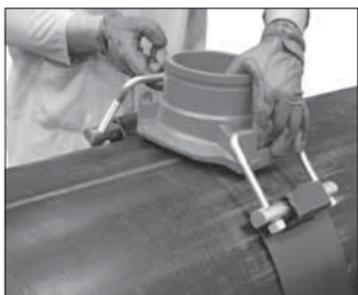
**8. BEFESTIGEN SIE DEN BÜGEL:** Ziehen Sie die zweite Bügelschraube an der gegenüberliegenden Rohrseite nach oben und haken Sie sie über den zweiten Haltekeil des Zapfengehäuses. **HINWEIS:** Wenn die Baugruppe nicht lang genug ist, um diesen Schritt auszuführen, lösen Sie die Muttern an den Bügelschrauben, um die Baugruppe zu verlängern.
