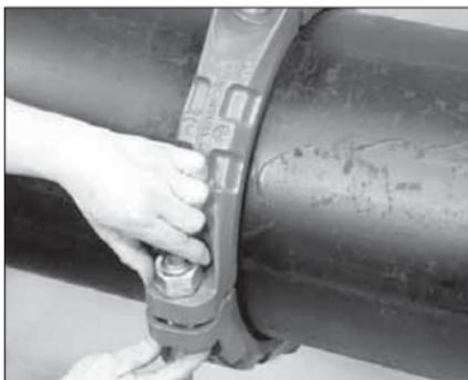
**3a. BRINGEN SIE DIE ERSTE VORMONTIERTE HÄLFTE AN:** Bringen Sie die erste vormontierte Hälfte über der Dichtung an. Stellen Sie sicher, dass die Federn der Gehäusehälften vollständig in die Nuten beider Gegenstücke eingreifen.
