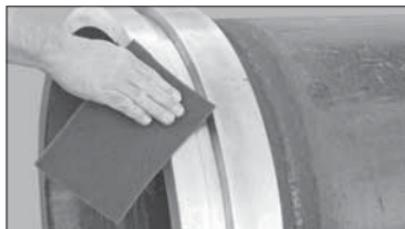
3. Reinigen Sie die Außenfläche der Vic-Rings, um Schmutz und andere Fremdkörper zu entfernen.
