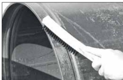
9. Reinigen Sie die Außenseite des Rohrs von der Nut bis zum Rohrende, um Öl, Fett, losen Lack und Schmutz zu entfernen.
