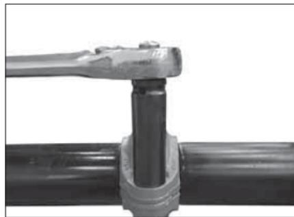
**5. ZIEHEN SIE DIE MUTTER AN:** Ziehen Sie die Mutter mit einem Schlagschrauber oder Standardsteckschlüssel mit langem Einsatz fest.
