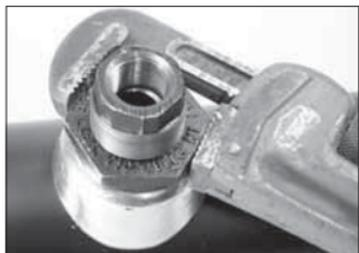
**7. ZIEHEN SIE DIE MONTAGEMUTTER MIT EINEM SCHRAUBENSCHLÜSSEL AN:** Ziehen Sie die Montagemutter mit einem Schraubenschlüssel an, bis sich der Ring verformt und das Rohr an allen Seiten gleichmäßig berührt. Behalten Sie die Ausrichtung von Ring/Dichtung bei, um Einklemmen der Dichtung zu verhindern.
