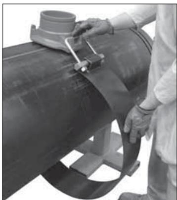
**7. BRINGEN SIE DEN BÜGEL AN:** Schieben Sie ein Ende des Bügels unter das Rohr und haken Sie eine Bügelschraube über den Haltekeil des Zapfengehäuses.
