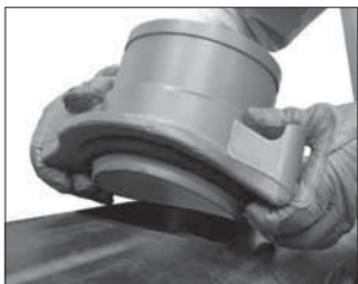
**6. BRINGEN SIE DAS GEHÄUSE AN:** Bringen Sie das Gehäuse an, indem der Positioniererring in die Auslassöffnung im Rohr eingeführt wird. Vergewissern Sie sich, dass der O-Ring in der Nut am Gehäuse bleibt und nicht in die Auslassöffnung fällt.
