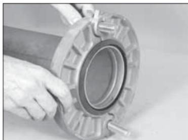
**7b.** Stecken Sie eine Standard-Vollschaff-Montageschraube durch die Schraubenlöcher der Überlappungsverbindungen an der gegenüberliegenden Seite.
