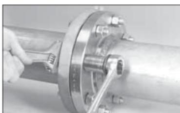
**10. ZIEHEN SIE DIE MUTTERN FEST:** Ziehen Sie alle Muttern gleichmäßig in der oben gezeigten Reihenfolge an, bis zwischen den Flanschflächen Metall auf Metall trifft, oder bis das erforderliche Drehmoment der Flanschschrauben für den Gegenflansch erreicht wird.
