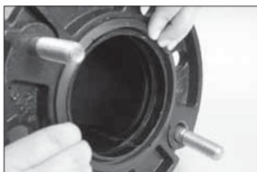
**6c.** Vergewissern Sie sich, dass die Flanschdichtung immer noch richtig in der Dichtungsaussparung des Typs 741, 841, 743 oder 744 sitzt und dass die Beschriftung an der Flanschdichtung nicht sichtbar ist, wenn die Vorderseite des Typs 741, 841, 743 oder 744 betrachtet wird.
