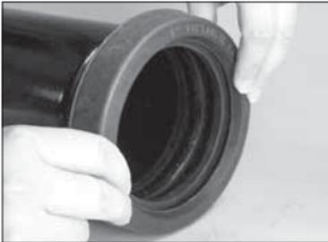
**4. BRINGEN SIE DIE DICHTUNG IN POSITION:** Die Dichtung des Typs HP-70ES hat einen Mittelsteg, der zwischen die Gegenstückenden passt. Führen Sie das genutete Ende eines Gegenstücks in die Dichtung ein, bis es den Mittelsteg der Dichtung berührt.
