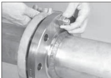
**8. VERBINDEN SIE DEN TYP 441 UND DEN GEGENFLANSCH:** Führen Sie die Montageschrauben, die in Schritt 5 und 7b angebracht wurden, in die Gegenflanschlöcher ein. Ziehen Sie auf jeder Schraube eine Mutter fest, damit die Schrauben nicht herausgezogen werden können.
