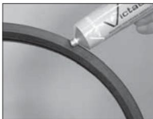
**6. SCHMIEREN SIE DIE DICHTUNG:** Tragen Sie eine dünne Schicht eines verträglichen Schmiermittels auf die Dichtlippen und die Außenseite der Dichtung auf. Siehe die Tabelle „Schmiermittelkompatibilität für Dichtungen“ auf Seite 34.
