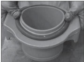
**5b. BRINGEN SIE DEN O-RING AN:** Drücken Sie den O-Ring in die Nut an der Unterseite des Zapfengehäuses. Setzen Sie den O-Ring NICHT auf das Rohr, um dann zu versuchen, den Positioniererring durch ihn zu schieben. Dadurch kann der O-Ring in die Auslassöffnung gedrückt werden, wodurch die ordnungsgemäße Abdichtung verhindert wird.
