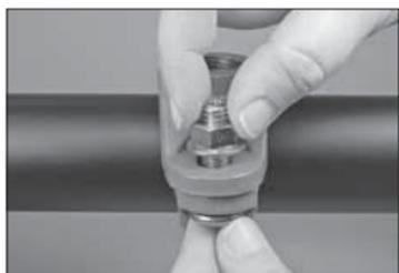
**4. BRINGEN SIE DIE ANDERE SCHRAUBE/ FLANSCHMUTTER AN:** Stecken Sie die andere Schraube durch die untere und die obere (Auslass)-Gehäusehälfte. Drehen Sie eine Flanschmutter auf die Schraube. **HINWEIS:** Vergewissern Sie sich, dass der ovale Hals der einzelnen Schrauben jeweils richtig in den Schraubenlöchern sitzt.
