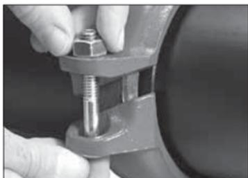
6. **BRINGEN SIE DIE ANDERE SCHRAUBE/ MUTTER AN:** Bringen Sie die andere Schraube an und drehen Sie die Mutter handfest auf die Schraube. **HINWEIS:** Vergewissern Sie sich, dass der ovale Hals der einzelnen Schrauben jeweils richtig in den Schraubenlöchern sitzt.
