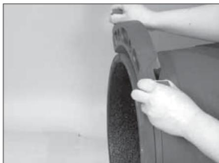
**2. BRINGEN SIE DAS ERSTE SEGMENT AN:** Bringen Sie das erste Segment am Rohr an. Vergewissern Sie sich, dass das Federteil des Segments vollständig in die Nut eingreift. **HINWEIS:** An vertikalen Rohren muss das Segment an seinem Platz abgestützt werden, bis alle Segmente angebracht und aneinander befestigt sind. An horizontalen Rohren kann das erste Segment wie links abgebildet oben auf dem Rohr ausbalanciert werden.
