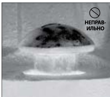
НЕПРАВИЛЬНОЕ ЗАЦЕПЛЕНИЕ БОЛТОВ (ОВАЛЬНАЯ ШЕЙКА НЕ УСТАНОВЛЕНА НАДЛЕЖАЩИМ ОБРАЗОМ В ОТВЕРСТИИ ПОД БОЛТ)
