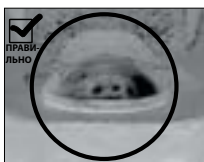
ОВАЛЬНЫЙ ПОДГОЛОВОК БОЛТА НАДЕЖНО ЗАФИКСИРОВАН
