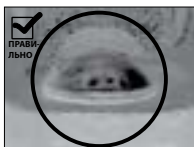
ОВАЛЬНЫЙ ПОДГОЛОВОК БОЛТА НАДЕЖНО ЗАФИКСИРОВАН
