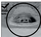
ОВАЛЬНЫЙ ПОДГОЛОВОК БОЛТА НАДЕЖНО ЗАФИКСИРОВАН
