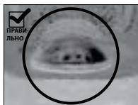
ОВАЛЬНЫЙ ПОДГОЛОВОК БОЛТА НАДЕЖНО ЗАФИКСИРОВАН
