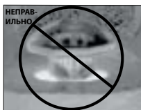
ОВАЛЬНЫЙ ПОДГОЛОВОК БОЛТА НЕ ЗАФИКСИРОВАН
