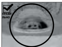
ОВАЛЬНЫЙ ПОДГОЛОВОК БОЛТА НАДЕЖНО ЗАФИКСИРОВАН
