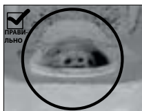
ОВАЛЬНЫЙ ПОДГОЛОВОК БОЛТА НАДЕЖНО ЗАФИКСИРОВАН
