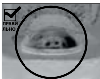
ОВАЛЬНЫЙ ПОДГОЛОВОК БОЛТА НАДЕЖНО ЗАФИКСИРОВАН
