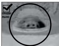
ОВАЛЬНЫЙ ПОДГОЛОВОК БОЛТА НАДЕЖНО ЗАФИКСИРОВАН
