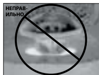
ОВАЛЬНЫЙ ПОДГОЛОВОК БОЛТА НЕ ЗАФИКСИРОВАН
