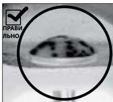
ОВАЛЬНЫЙ ПОДГОЛОВОК БОЛТА НАДЕЖНО ЗАФИКСИРОВАН
