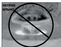
ОВАЛЬНЫЙ ПОДГОЛОВОК БОЛТА НЕЗАФИКСИРОВАН
