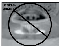
ОВАЛЬНЫЙ ПОДГОЛОВОК БОЛТА НЕ ЗАФИКСИРОВАН
