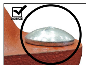
PRAWIDŁOWO OSADZONA OWALNA SZYJKA ŚRUBY
