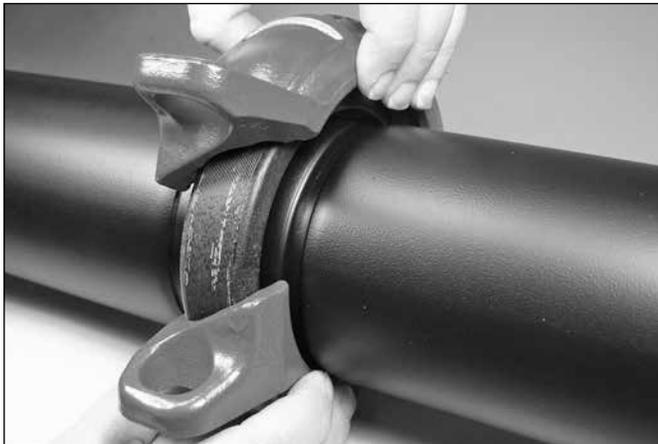
**7. INSTALE LOS SEGMENTOS:** Instale los segmentos sobre la empaquetadura. Asegúrese de que las cuñas de los segmentos encajen completamente en las ranuras de ambas tuberías o componentes acoplados.
