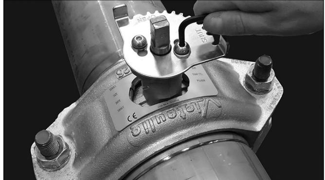
4. Nehmen Sie die beiden Kopschrauben und Unterlegscheiben und dann die Rasterhebelplatte ab.
