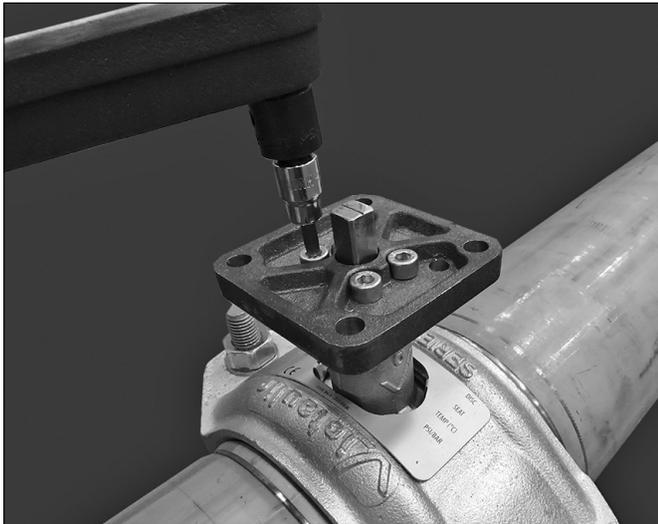
8. Tragen Sie ein Gewindegewand auf die Kopfschrauben auf. Drehen Sie die Kopfschrauben ein, um die Adapterplatte für den Antrieb am Flansch zu befestigen. **Ziehen Sie alle Kopfschrauben auf 28 – 30 ft-lbs/38 – 41 N•m an.**
