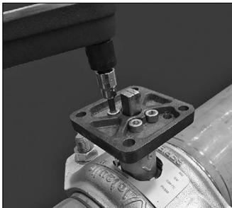
3. Aplique sellador de rosca a los tornillos de cabeza. Introduzca los tornillos para sujetar la placa a la brida. **Apriete los tornillos a un par de apriete de 28 – 30 ft-lbs/ 38 – 41 N•m.**
