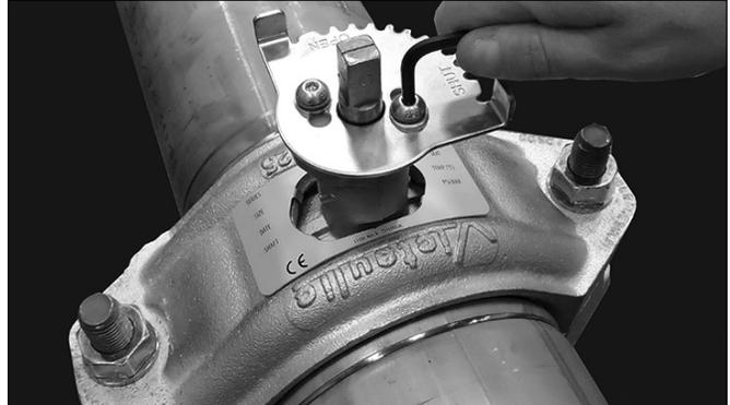
4. Quite los dos tornillos y arandelas y saque la placa de la palanca de bloqueo.
