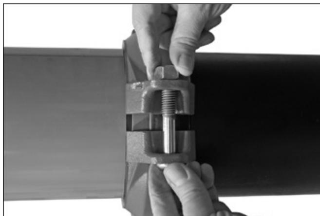
**4. INSTALE LOS SEGMENTOS:** Instale los segmentos sobre la empaquetadura. Verifique que los lados de los dos segmentos marcados “CPVC/PVC” estén dirigidos hacia las tuberías de CPVC/PVC y las cuñas de los segmentos se inserten completamente en las ranuras de ambos componentes acoplados.
