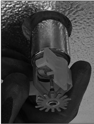
1. Después de que haya instalado correctamente el rociador seco de acuerdo con las Instrucciones de Instalación y Mantenimiento I-40 para rociadores automáticos Victaulic® FireLock™, retire temporalmente el protector del bulbo del rociador. Proceda con precaución al retirar al protector del bulbo para no dañar el bulbo, el deflector ni los brazos del marco. NO use herramientas para retirar el protector de bulbo.
