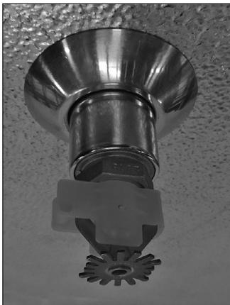
3. Reinstale el protector del bulbo en el rociador hasta que el sistema de rociadores sea puesto en servicio. Proceda con precaución al reinstalar el protector del bulbo para no dañar el bulbo, el deflector ni los brazos del marco. NO use herramientas para reinstalar el protector de bulbo.
