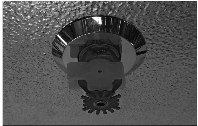
1. Instale el rociador seco de acuerdo con las Instrucciones de Instalación y Mantenimiento I-40 para rociadores automáticos Victaulic® FireLock™. Verifique que la placa a ras esté en pleno contacto con el cielo falso o pared del congelador, como se muestra arriba.
