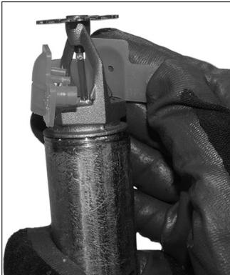
**1a.** Retire temporalmente el protector del bulbo del rociador. Proceda con precaución al retirar al protector del bulbo para no dañar el bulbo, el deflector ni los brazos del marco. NO use herramientas para retirar el protector de bulbo.
