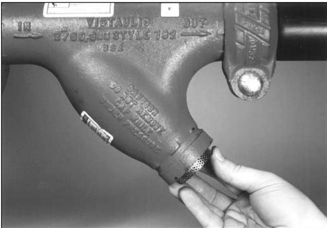
2. 转动过滤器滤篮：必要时，转动过滤器滤篮，使伸出过滤器器体的长度最短。
