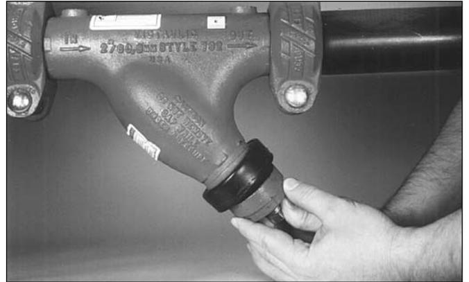
2. 拆除接头、密封垫圈和检修盖：支撑好检修盖，松开螺栓，拆除检修接头。在拆除密封垫圈和检修盖时，请做好支撑过滤器滤篮的准备。
