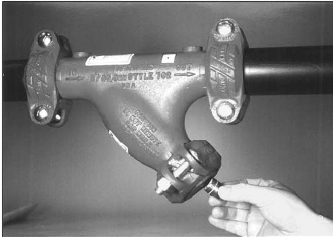
1. 拆除管塞：确保已给系统完全卸压并排干积液。从检修盖上拆除管塞或打开下吹阀，排出系统积液。
