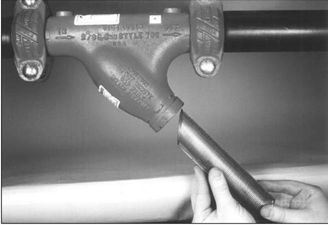
1. 定位放置过滤器滤篮：让过滤器滤篮切有斜角的一端对好方向，以便正确地插入器体中，如上图所示。
