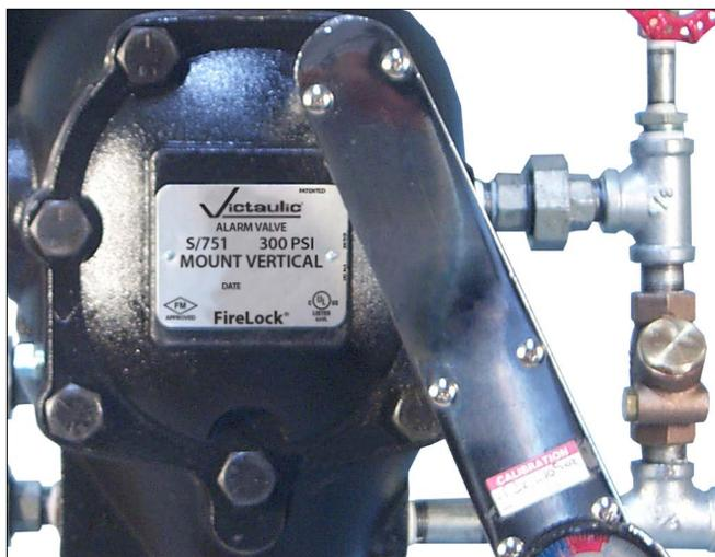
4. Выровняйте на клапане крышку с уплотнением. Убедитесь, что серги пружины повернуты в установленном направлении. Затяните все болты крышки на крышке/корпусе клапана.
