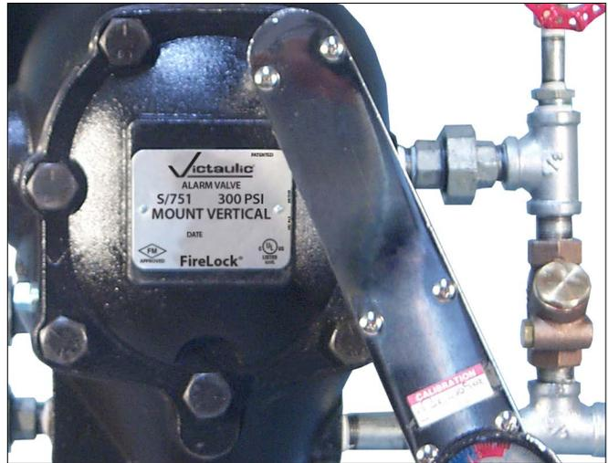
4. Alinee la cubierta/empaquetadura de cubierta con la válvula. Verifique que los brazos del resorte de la clapeta se giren a su posición instalada. Apriete todos los pernos de la cubierta en la cubierta/cuerpo de la válvula.
