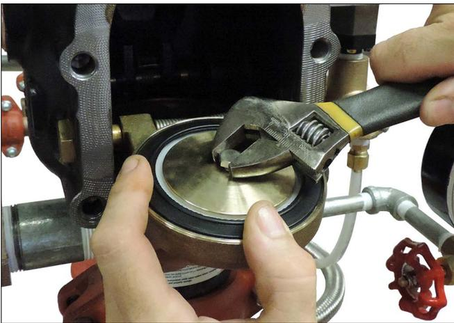
21. Ziehen Sie die Schraube der Dichtungsbaugruppe/Schraubendichtung auf das in der untenstehenden Tabelle angegebene Drehmoment an, um eine gute Dichtung zu gewährleisten.
