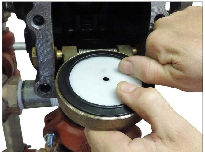
19. Bringen Sie die neue Klappendichtung (im Lieferumfang des Bausatzes enthalten) sorgfältig in der Klappe an. Stellen Sie sicher, dass der Dichtungsring vollständig in die Klappe einrastet.
