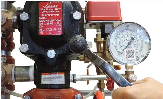
1. Wenn das System drucklos ist, lösen Sie die Schrauben der Abdeckung langsam. **HINWEIS:** Nehmen Sie die Schrauben der Abdeckung ERST ab, wenn alle Schrauben der Abdeckung gelockert sind.
