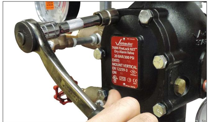
23. Richten Sie die Abdeckung/Dichtung der Abdeckung mit der Ventilstation aus. Stellen Sie sicher, dass die Arme der Klappenfeder in ihre Installationsposition gedreht werden. Ziehen Sie alle Schrauben der Abdeckung auf der Abdeckung/dem Ventilgehäuse an.
