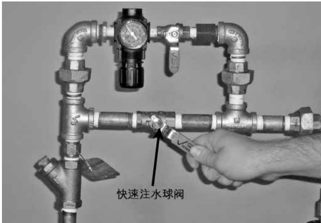
9. 对于气动(干式先导)释放系统: 打开AMTA上的快充球阀。让压力重新回到正常系统压力。
