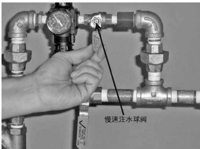
9. 对于气动（干式先导）释放系统：关闭AMTA上的慢充球阀。
