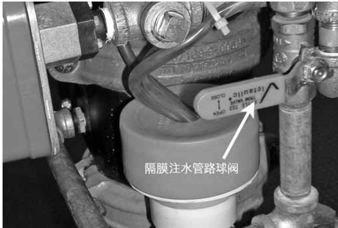
7. 关闭隔膜注水管路球阀。
