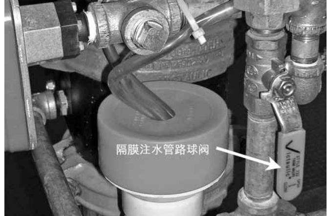
4. 打开隔膜注水管路球阀。
