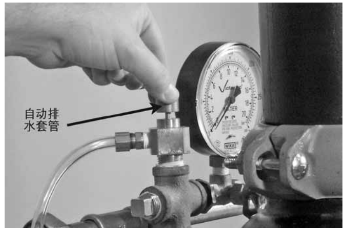
4. 打开隔膜注水管路球阀。
