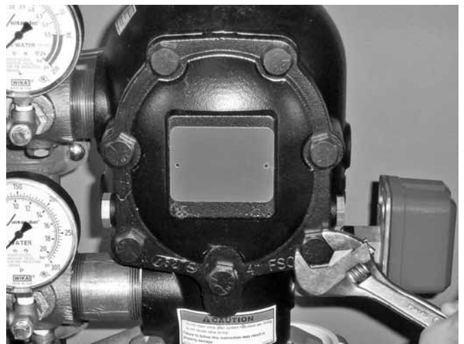
11. 在释放完系统内的全部压力后，缓慢松开阀盖螺栓。说明：在松开全部阀盖螺栓之前，切勿拆除任何阀盖螺栓。
