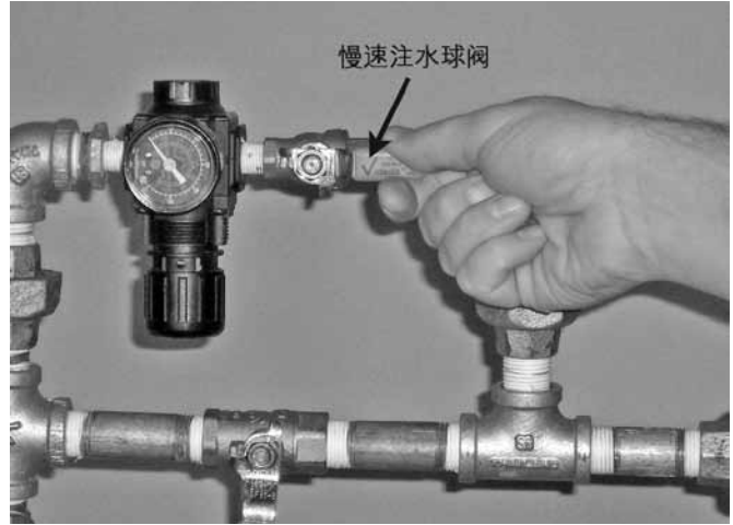
11. 对于气动(干式先导)释放系统: 开启AMTA上的慢充球阀。
