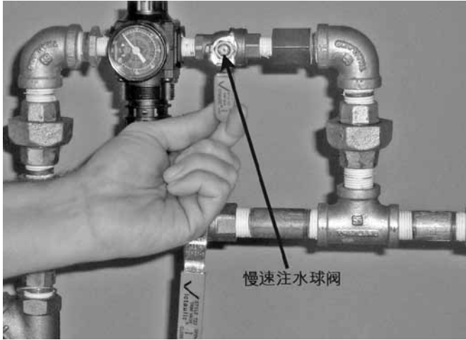
8. 对于气动(干式先导)释放系统: 关闭AMTA上的慢充球阀。
