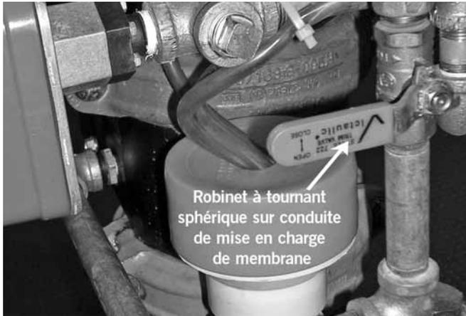
7. Fermer le robinet à tournant sphérique sur conduite de mise en charge de membrane.
