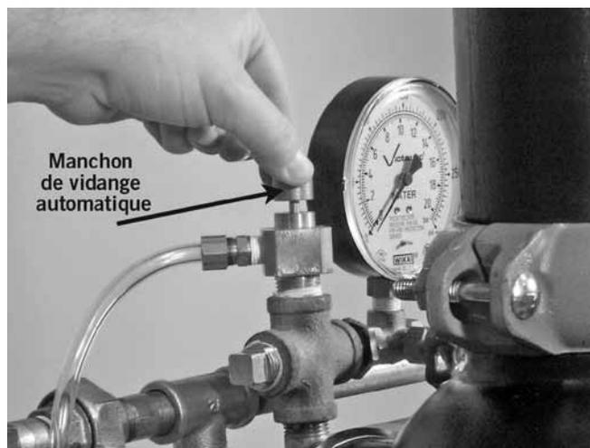
15. En tirant, lever le manchon de vidange automatique jusqu'à ce que la vis soit en position « réglée » (« UP [haut] »). Vérifier que le manomètre sur la conduite de mise en charge de membrane indique une pression.
