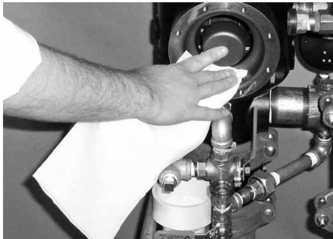
3. Retirer les vis de fixation du couvercle de la membrane et sortir ce dernier du clapet, ainsi que les pièces internes, en soulevant.
