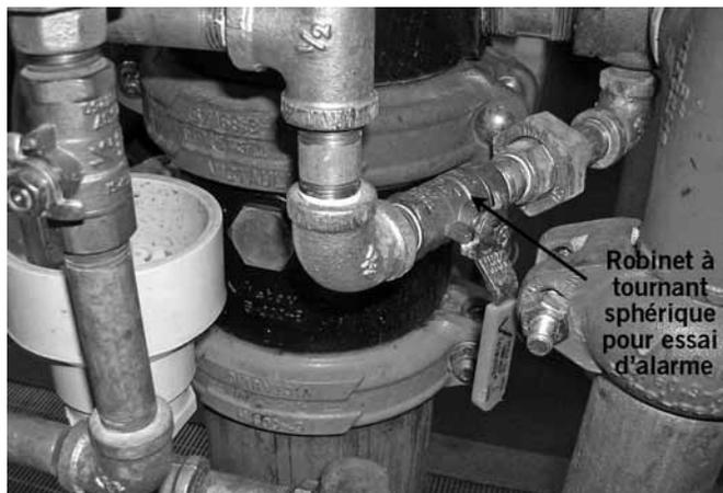
6. Fermer le robinet à tournant sphérique d'essai d'alarme, une fois la vérification du bon fonctionnement des alarmes terminée.
