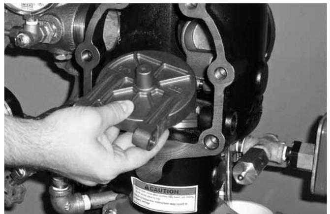
4. Retirer le disque du corps du clapet.
