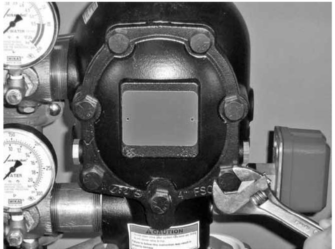
11. Lorsqu'il n'y a plus de pression dans le système, desserrer lentement les boulons de la plaque-couvercle. **NOTE :** NE retirer AUCUN boulon de plaque-couvercle tant que tous les boulons n'ont pas été desserrés.
