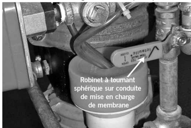
16. Lorsque la conduite de mise en charge de la membrane est sous pression, fermer temporairement le robinet à tournant sphérique sur cette conduite. Vérifier que la pression se maintient dans la conduite de mise en charge de la membrane au moyen du manomètre sur cette conduite.
