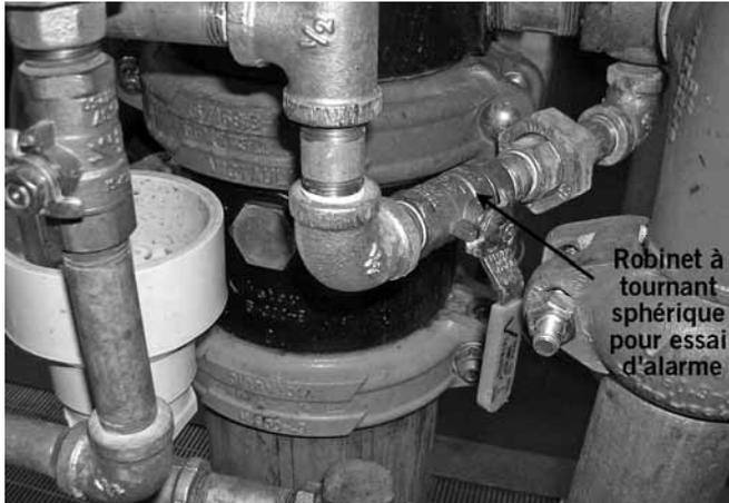
7. Vérifier que le robinet à tournant sphérique pour essai d'alarme est fermé.
