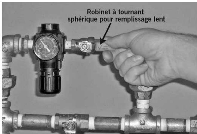
11. **SYSTÈMES DE DÉCLENCHEMENT PNEUMATIQUE (PILOTE SOUS AIR) :** Ouvrir le robinet à tournant sphérique pour remplissage lent sur le dispositif de maintien de la pression d'air (AMTA). **NOTE :** lorsqu'on omet de laisser ouvert le robinet à tournant sphérique pour remplissage lent, la pression dans le système risque de chuter, entraînant le fonctionnement du clapet en cas de fuite dans le système.
