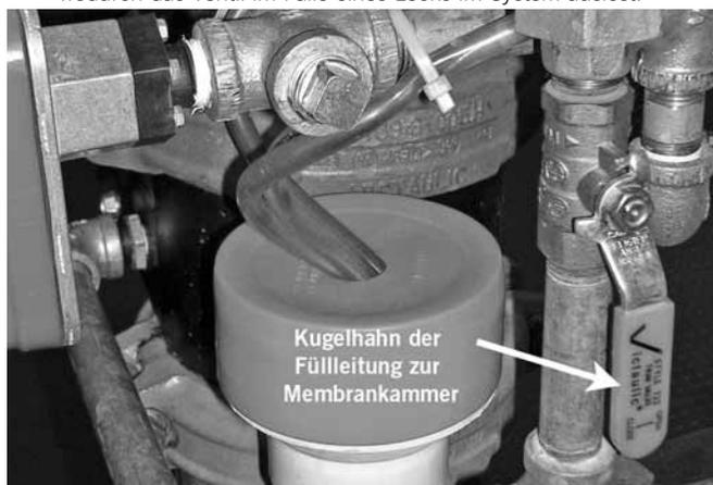
12. Öffnen Sie den Kugelhahn der Füllleitung der Membran. Lassen Sie Wasser durch das Rohr der automatischen Entleerung fließen.
