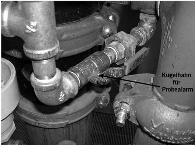
5. Öffnen Sie den zur Überprüfung des Alarms vorgesehenen Kugelhahn. Stellen Sie sicher, dass die mechanischen und elektrischen Warneinrichtungen aktiviert sind und dass entfernt liegende Überwachungsstationen, falls vorhanden, ein Alarmsignal erhalten.
