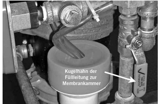
4. Öffnen Sie den Kugelhahn der Füllleitung zur Membrankammer.
