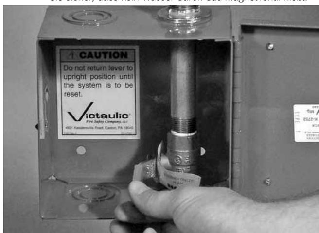
13. Öffnen Sie den Kugelhahn zur manuellen Auslösung des Systems, um möglicherweise vorhandene Luft abzulassen.
