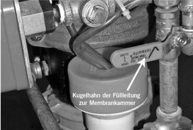
7. Den Kugelhahn der Füllleitung zur Membrankammer schließen.
