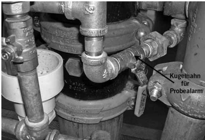
6. Schließen Sie, nachdem Sie das ordnungsgemäße Funktionieren aller Warneinrichtungen verifiziert haben, den zur Überprüfung des Alarms vorgesehenen Kugelhahn.
