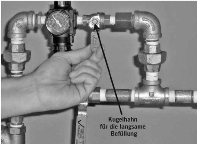
8. **FÜR SYSTEME MIT PNEUMATISCHER AUSLÖSUNG (TROCKENES ANREGERSYSTEM):** Schließen Sie den zur langsamen Befüllung vorgesehenen Kugelhahn an der AMTA.
