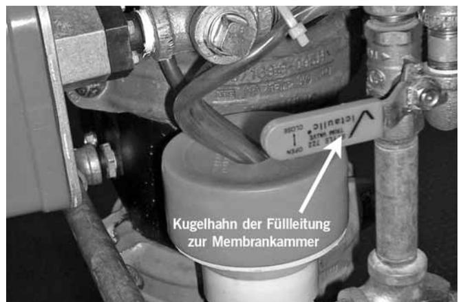
16. Wenn die Füllleitung zur Membrankammer mit Druck beaufschlagt ist, den Kugelhahn der Füllleitung vorübergehend schließen. Am Manometer für die Füllleitung überprüfen, dass die Leitung den Druck beibehält.
