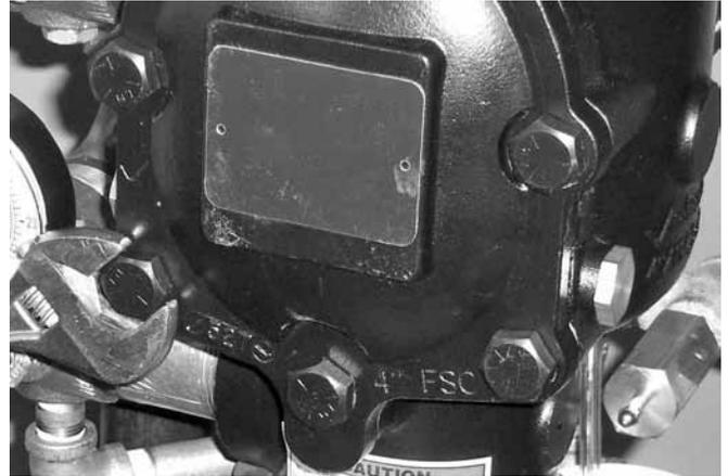
4. Die Abdeckung/Dichtung mit der Ventilstation ausrichten. Sicherstellen, dass die Arme der Klappenfeder in die installierte Stellung gedreht wurden. Alle Schrauben der Abdeckung in das Ventilstationengehäuse einschrauben und festziehen.
