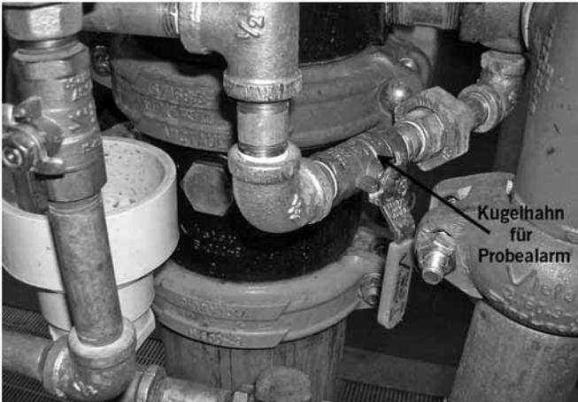
7. Stellen Sie sicher, dass der zur Überprüfung des Alarms vorgesehene Kugelhahn geschlossen ist.
