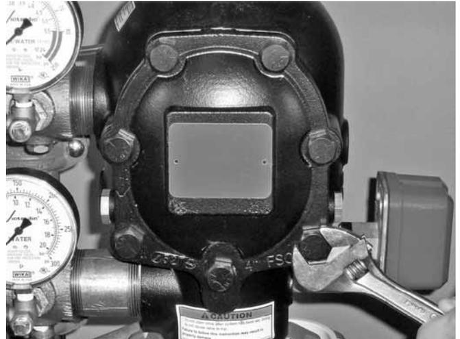
11. Wenn das System ganz drucklos ist, die Schrauben an der Abdeckung langsam abnehmen. **ANMERKUNG:** Die Schrauben an der Abdeckung NICHT abnehmen, bis alle Schrauben an der Abdeckung gelockert sind.
