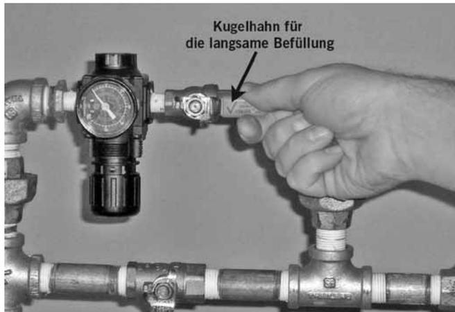
11. **FÜR SYSTEME MIT PNEUMATISCHER AUSLÖSUNG:** Öffnen Sie den Kugelhahn für die langsame Befüllung an der AMTA.
