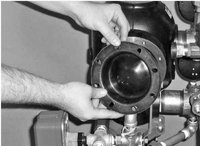
4. Die Membran vom Ventilstationgehäuse abnehmen.
