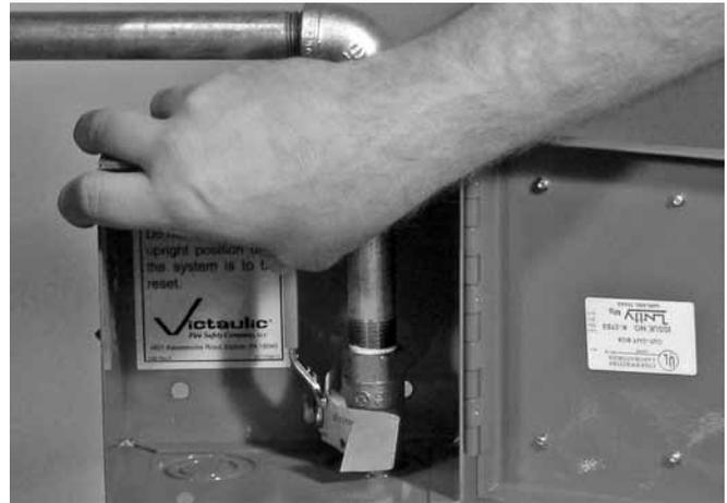
14. Schließen Sie den Kugelhahn der Handauslösung.
