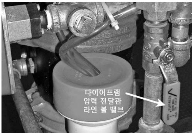
12. 다이어프램 압력 전달관의 볼 밸브를 여십시오. 물이 오토 드레인 튜브를 통해 흐르게 하십시오. 12a. 전기식 릴리즈 시스템에서: 솔레노이드를 통해 물이 흐르지 않는지 확인합니다.
