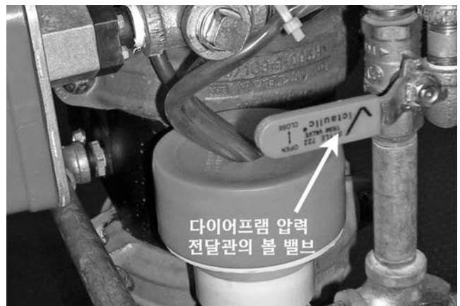
16. 다이어프램 압력 전달관이 압력을 받고 있을 때, 다이어프램 압력 전달관의 볼 밸브를 일시적으로 닫아 주십시오. 다이어프램 압력 전달관의 압력 게이지를 살펴 다이어프램 압력 전달관의 압력이 유지되고 있는지 확인해 주십시오.
