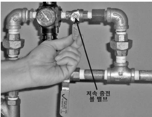
9. 공압식 (건식 파일럿) 릴리즈 시스템에서: 에어 공급트림 어셈블리(압력 스위치 부착형)의 저속 충전 볼 밸브를 닫으십시오.
