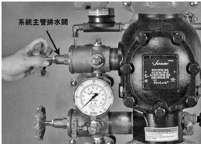
1. 開啟系統主管排水閥。確認系統已確實排水。
