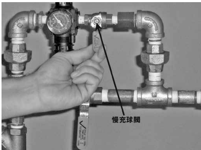
9. 對於氣動（乾式先導）釋放系統：關閉AMTA上的慢充球閥。
