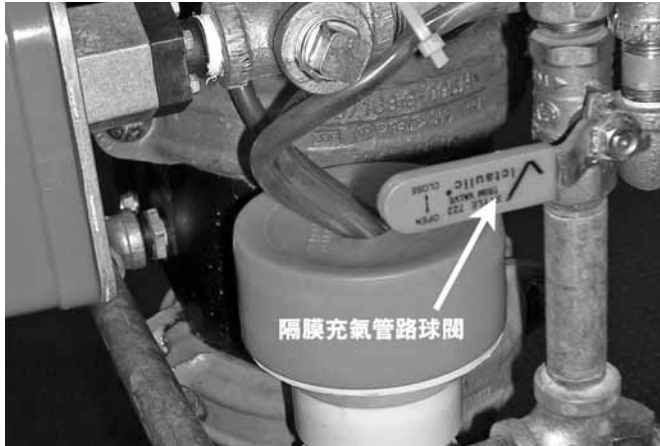
7. 關閉隔膜注水管路球閥。
