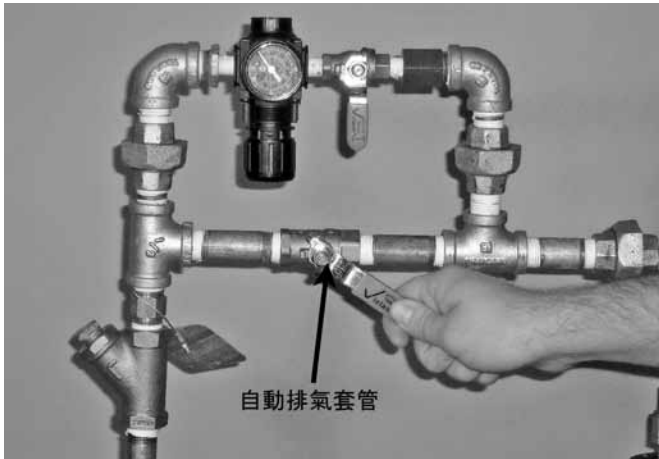
9. 對於氣動(乾式先導)釋放系統:打開AMTA上的快充球閥。讓壓力重新回到正常系統壓力。
