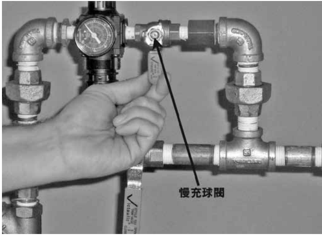
8. 對於氣動(乾式先導)釋放系統:關閉AMTA上的慢充球閥。
