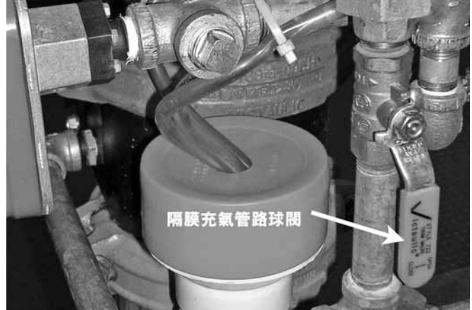
4. 打開隔膜注水管路球閥。
