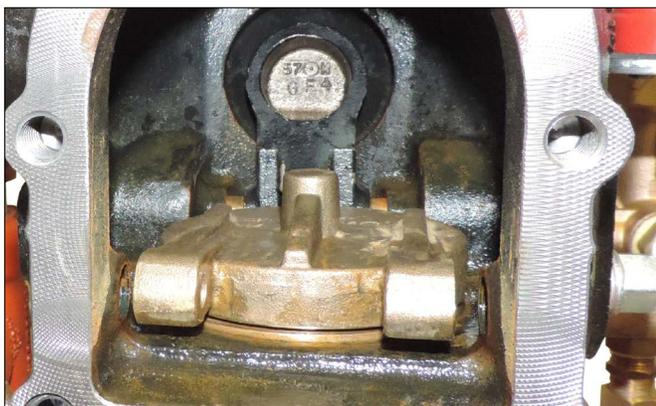
5. Poser le clapet à battant neuf sur la bague de siège du corps de clapet. S'assurer que les trous du bras de clapet à battant s'alignent sur les trous du corps de clapet.
