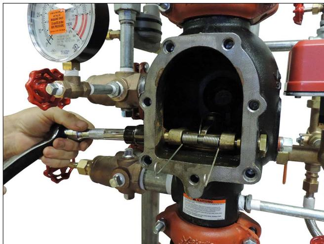
9. S'assurer de placer un joint torique sur chacun des manchons de la tige du clapet à battant.
