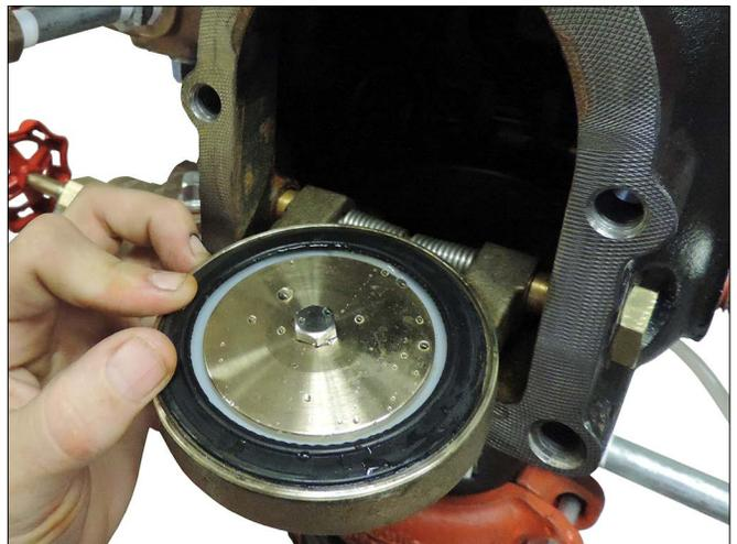
14. Faire pivoter le clapet à battant hors du corps de clapet. Inspecter le joint de clapet à battant et le disque de retenue d'étanchéité. Essuyer les contaminants, la saleté et les dépôts minéraux. Nettoyer tout orifice obstrué dans la bague de siège du corps de clapet. **NE PAS UTILISER DE SOLVANTS NI D'ABRASIFS.**
