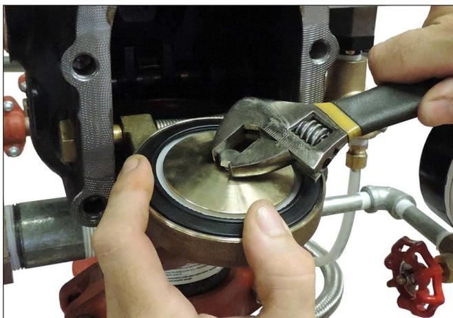
11. Serrer le boulon d'étanchéité au couple prescrit dans le tableau ci-dessous pour assurer une étanchéité adéquate.
