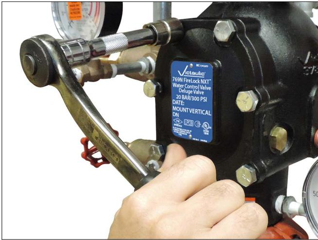
4. Allineare la piastra di copertura/guarnizione alla valvola. Verificare che i bracci della molla del clapet siano ruotati nella posizione in cui erano stati installati. Serrare tutti i bulloni della piastra di copertura nella piastra di copertura/corpo della valvola.
