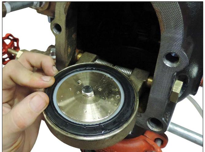
14. Ruotare il clapet per estrarlo dal corpo della valvola. Ispezionare la tenuta clapet e la ghiera di tenuta. Eliminare i contaminanti, la sporcizia e i depositi minerali. Pulire ogni foro ostruito nell'anello della sede del corpo della valvola. **NON UTILIZZARE SOLVENTI O ABRASIVI.**
