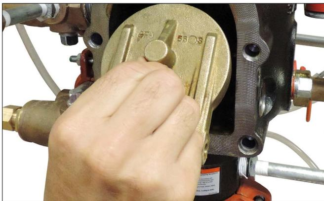
4. Rimuovere il gruppo clapet dall'anello di sede del corpo della valvola. Pulire l'anello di sede del corpo della valvola.
