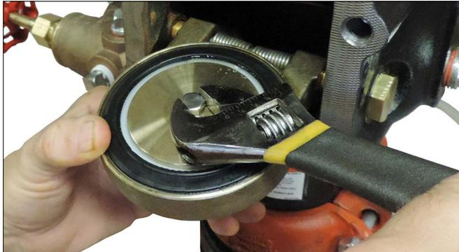
2. Rimuovere il bullone di assemblaggio/tenuta del bullone dalla tenuta del clapet.
