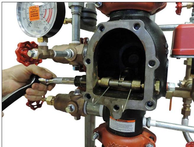
9. Verificare che un O-ring della boccola dell'albero del clapet sia installato in ogni boccola dell'albero del clapet.
