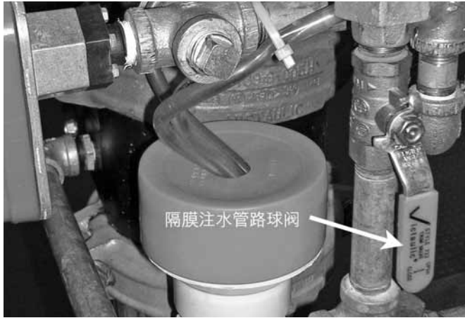
5. 打开隔膜注水管路球阀。
