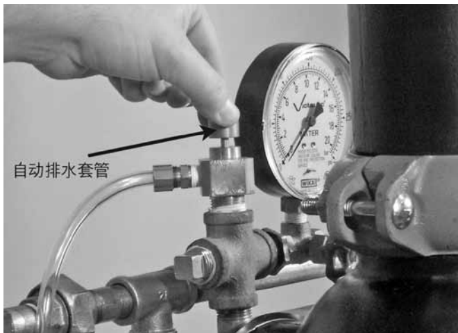
5. 打开隔膜注水管路球阀。
