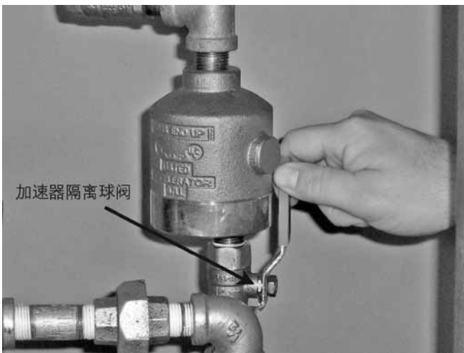
13. 如果安装了746-LPA系列干式加速器, 请打开隔离球阀。
