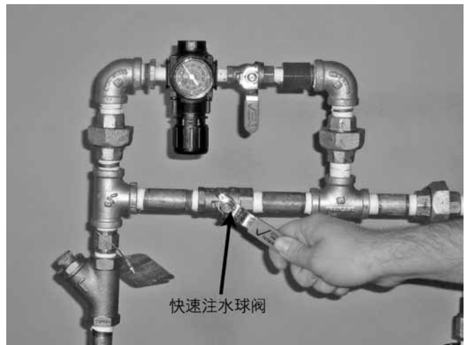
10. 打开AMTA上的快充球阀。让压力重新回到正常系统压力。
