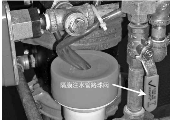
22b. 如果隔膜注水管路内的压力没有下降，请重新打开隔膜注水管路球阀，转入下一步。
