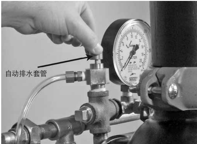
21. 提起自动排水套管至螺钉处于就位（“升起”）位置。确认隔膜注水管路上的压力表显示有压力。
