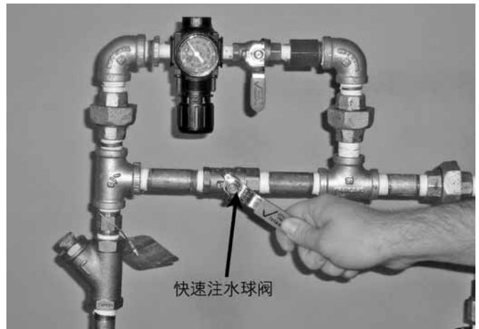
10. 确认报警测试球阀已关闭。
