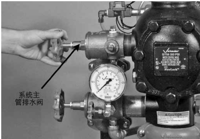
6. 缓慢部分开启系统主管排水阀。确认水没有从排水管流出。说明：如果水从排水管流出，则系统可能还没有正确排干积水。在这种情况下，请遵照执行“让系统投入运行”一节中的所有步骤。
