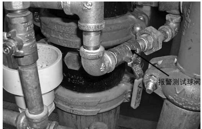
10. 确认报警测试球阀已关闭。
