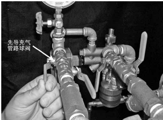
11. 打开先导充气管路中的球阀, 将其扳至“OPEN – FAST-FILL (开启—快充) 位置。”让压力重新升至正常压力。
