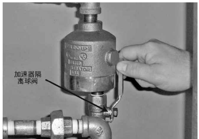
14. 如果安装了746-LPA系列干式加速器, 请打开隔离球阀。
