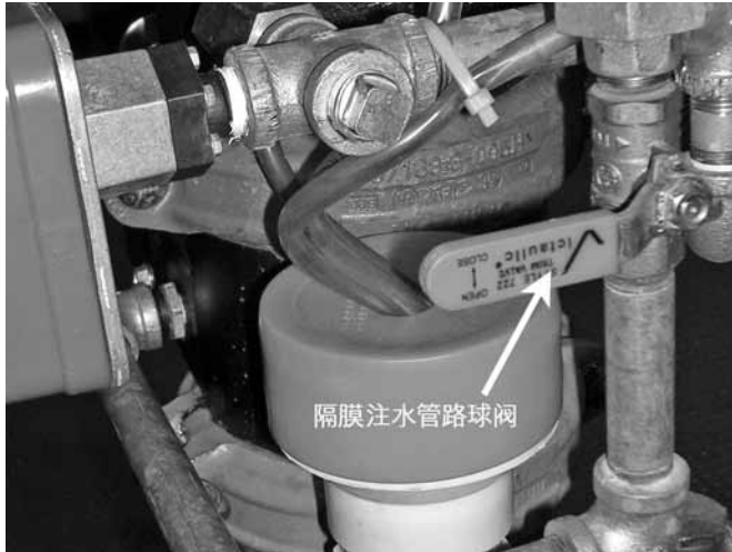
7. 关闭隔膜注水管球阀。
