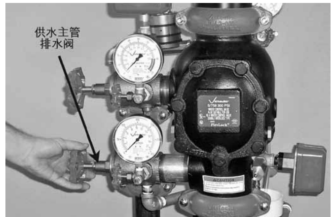
17. 出现稳定水流时，关闭供水主管排水阀。
