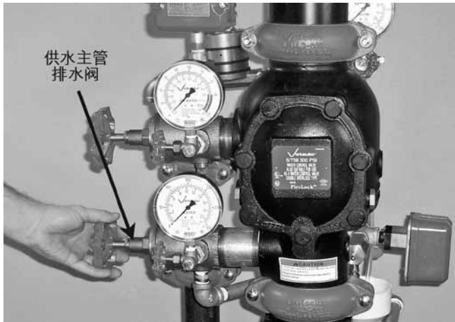
4. 关闭供水主管排水阀。
