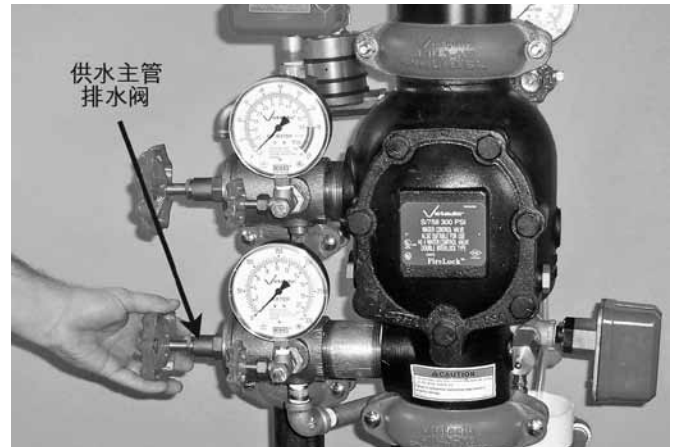
27. 出现稳定水流时，关闭供水主管排水阀。
