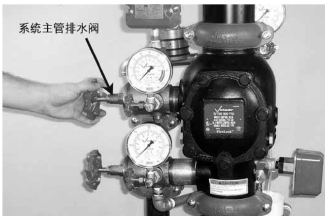
6. 缓慢部分开启系统主管排水阀。确认水没有从排水管流出。 说明: 如果水从排水管流出, 则系统可能还没有正确排干积水。在这种情况下, 请遵照执行“让系统投入运行”一节中的所有步骤。
