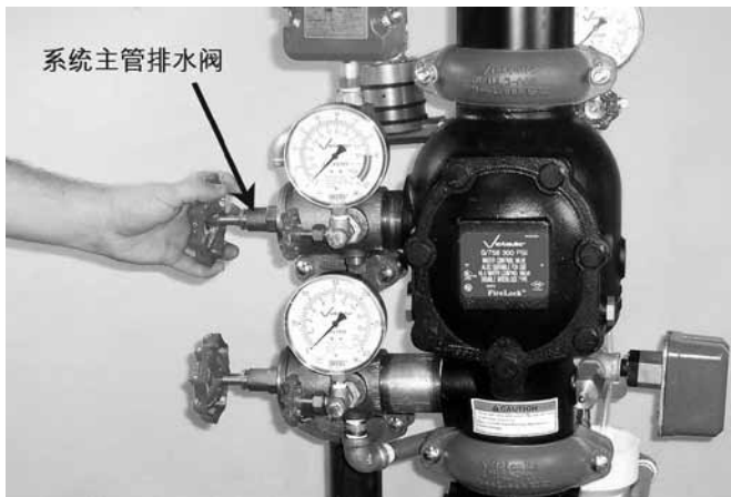
8. 打开系统主管排水阀，排出所有积水，并释放系统气压。 说明：如果系统运行过，请打开系统远程测试阀（检查员测试连接）与所有辅助排水阀。
