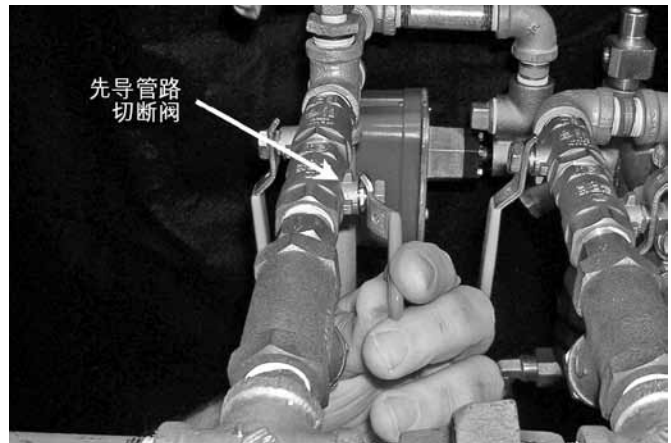
9. 关闭先导管路中的“SHUT-OFF (切断)”阀 (黄色手柄)。
