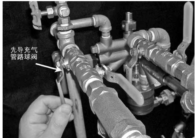
12. 当系统压力达到最低不小于13 psi/90 kPa/0.9 Bar时, 请关闭先导充气管路中的球阀, 将其扳至“CLOSED – RESTRICTED FILL (关闭—限制充气)”位置。
