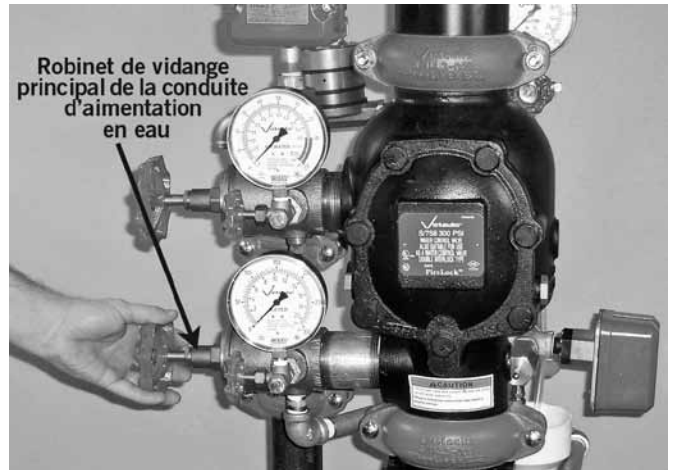
Robinet à tournant sphérique pour charge ce conduite du système
