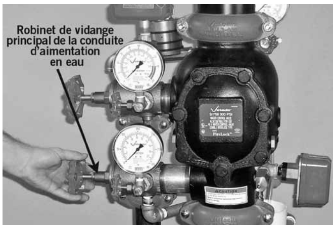
25. Ouvrir le robinet de vidange principal de la conduite d'alimentation en eau.
