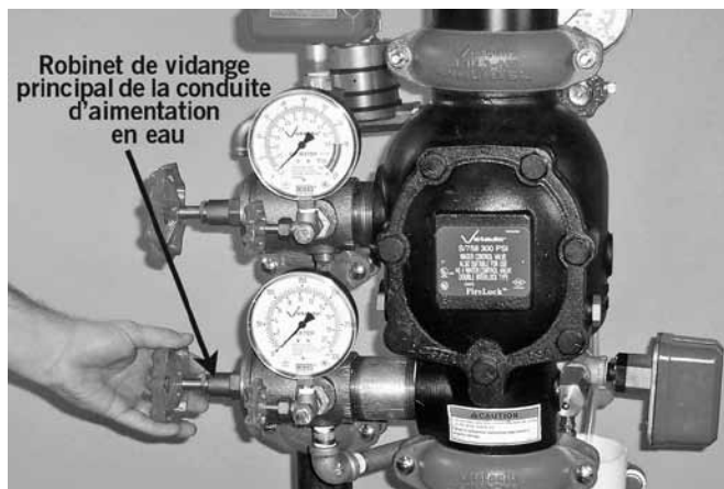
27. Une fois l'écoulement d'eau stabilisé, fermer le robinet de vidange principal de la conduite d'alimentation en eau.
