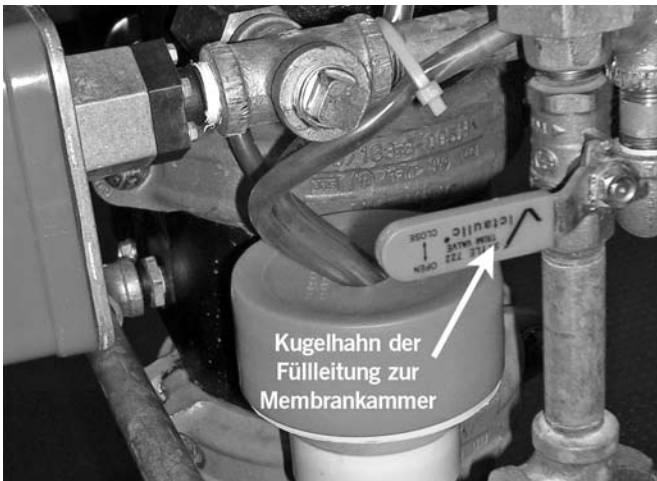
21. Schließen Sie den Kugelhahn der Füllleitung zur Membrankammer vorübergehend, wenn diese druckbeaufschlagt ist. Stellen Sie sicher, dass die Füllleitung zur Membrankammer den Druck aufrechterhält, indem Sie deren Manometer beobachten.
