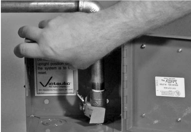
19. Schließen Sie den Kugelhahn der Handauslösung.
