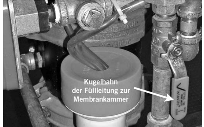
21b. Wenn der Druck in der Füllleitung zur Membrankammer aufrechterhalten wird, öffnen Sie deren Kugelhahn wieder und fahren Sie mit dem nächsten Schritt fort.
