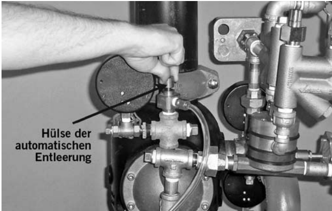
20. Ziehen Sie die Hülse der automatischen Entleerung solange nach oben, bis die Schraube sich in der Betriebs- („nach oben“) Position befindet. Stellen Sie sicher, dass am Manometer zur Füllleitung der Membran Druck anliegt.
