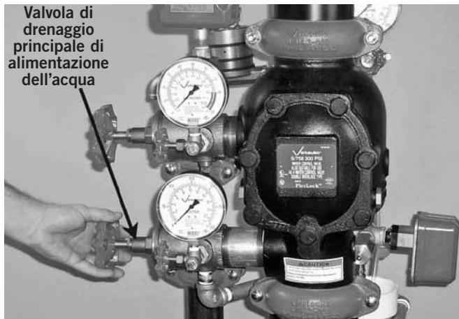
25. Aprire la valvola di drenaggio principale di alimentazione dell'acqua.
