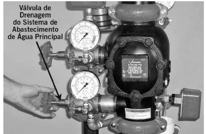
17. Feche a válvula principal de drenagem do fornecimento de água quando houver um fluxo uniforme de água.
