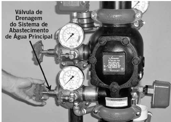
15. Abra a válvula principal de drenagem do fornecimento de água.
