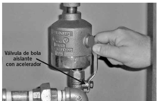
23. Si instala un acelerador seco LPA Serie 746, abra la válvula de bola aislante. Esto lanzará el acelerador.
