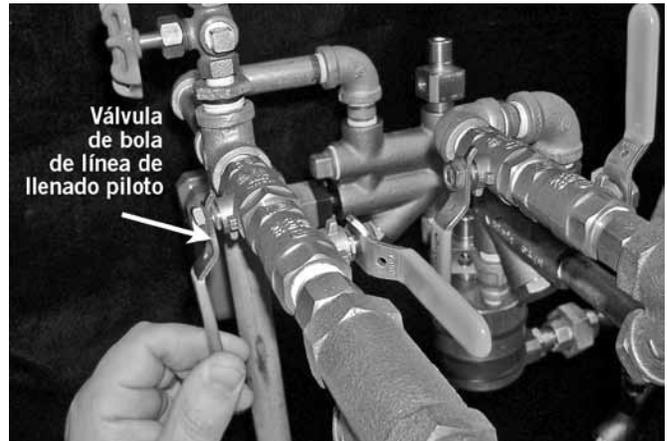
12. Cuando haya presión de aire en la línea piloto, cierre la válvula de bola en la línea de llenado piloto y póngala en posición "CERRADA – LLENADO RESTRINGIDO".
