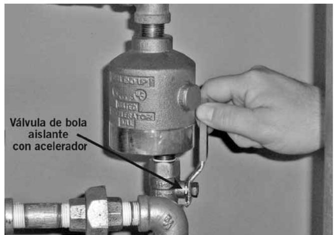
14. Si instala un acelerador seco Serie 746-LPA, abra la válvula de bola aislante.
