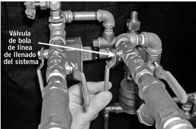
16. Cuando haya presión de aire en el sistema, ponga la válvula de bola en la línea de llenado del sistema en posición "CERRADA - LLENADO RESTRINGIDO".
