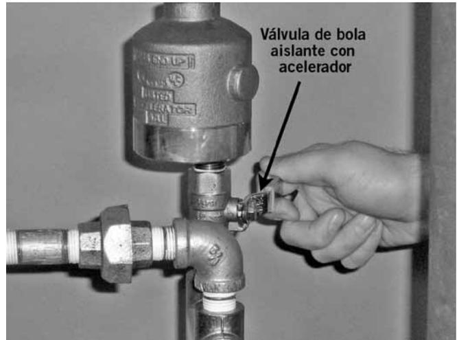
4. Si instala un acelerador seco LPA Serie 746, confirme que la válvula de bola aislante al acelerador está cerrada.
