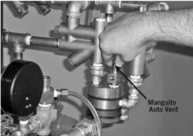
15. Cuando el sistema alcance unos 10 psi/69 Kpa/0,7 bar de presión y ya no salga humedad del Auto Venteo, tire del manguito Auto Venteo de la cámara del sistema en el actuador neumático/neumático Serie 798. **NOTA:** El perno del Auto Venteo de la cámara del sistema debe sellar y quedarse en posición ("UP").
