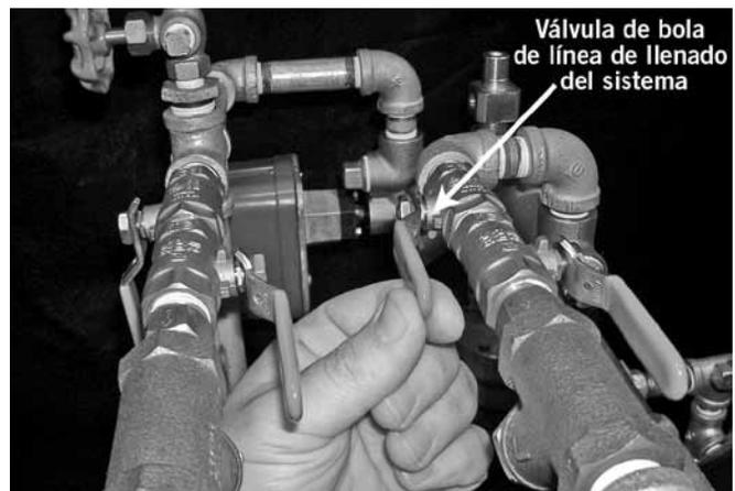
14. Ponga la válvula de bola en la línea de llenado del sistema en posición "ABIERTA – LLENADO RÁPIDO". Cargue la línea piloto con un mínimo de 13 psi/90 Kpa/0,9 bar. Consulte el capítulo "Requisitos del suministro de aire".
