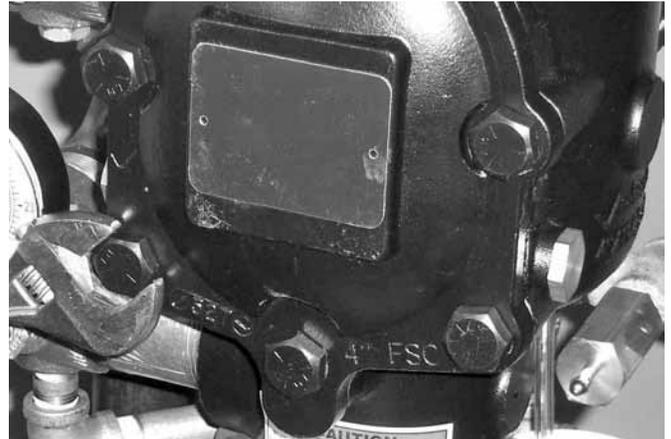
4. Alinee la tapa/junta de la tapa con la válvula. Asegúrese de que los muelles de la clapeta están girados en su posición de instalación. Apriete todos los pernos de la tapa a la tapa/cuerpo de la válvula.
