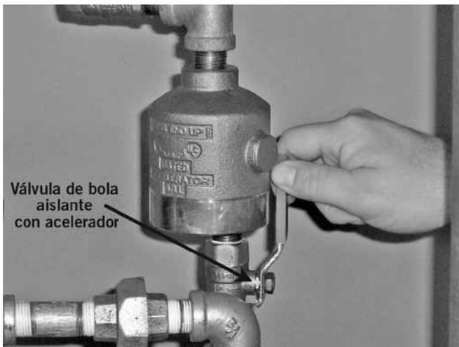
13. Si instala un acelerador seco Serie 746-LPA, abra la válvula de bola aislante.
