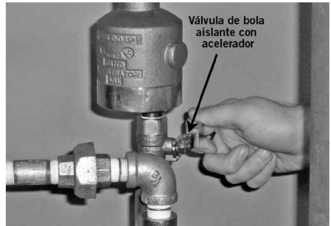
2. Si instala un acelerador seco Serie 746-LPA, cierre la válvula de bola aislante.
