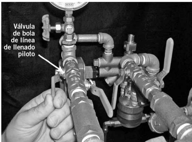
11. Ponga la válvula de bola en la línea de llenado piloto en posición "ABIERTA - LLENADO RÁPIDO". Vuelva a poner la presión normal.
