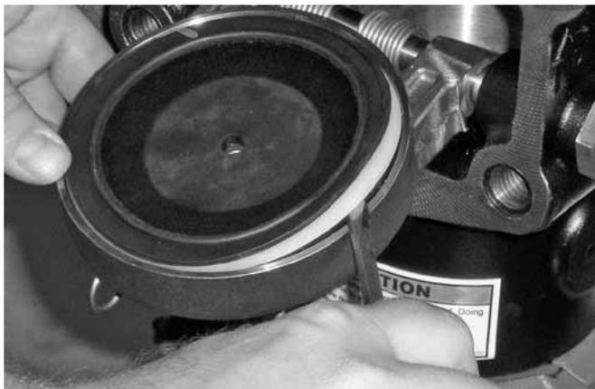
6. Saque la junta del cierre de clapeta, junto con el anillo de sellado. Inspecciónela. Si está torcida o rota, sustituya el conjunto por uno nuevo suministrado por Victaulic y vaya al paso 7.
