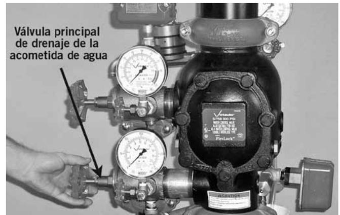
3. Abra completamente la válvula del drenaje principal de la acometida de agua para limpiar las tuberías de materiales contaminantes.
