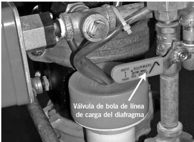
21. Cuando la línea de carga del diafragma esté bajo presión, cierre temporalmente la válvula de bola de línea de carga del diafragma. Confirme que la línea de carga del diafragma mantiene la presión observando el indicador de presión de línea de carga del diafragma.
