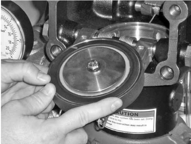
13. Gire la clapeta y sáquela del cuerpo de la válvula. Inspeccione el sellado de la clapeta y el retén de sellado. Limpie cualquier rastro de suciedad y depósitos minerales. Limpie todos los orificios del anillo de asiento del cuerpo de la válvula. **NO USE DISOLVENTES NI PRODUCTOS ABRASIVOS.**
