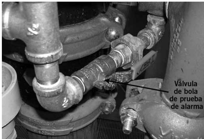
4. Abra la válvula de bola de prueba de alarma. Confirme que las alarmas mecánicas y eléctricas están activadas y que las estaciones de control remoto, si las hay, reciben una señal de alarma.
