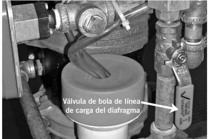
17. Abra la válvula de bola de línea de carga del diafragma. Deje que el agua pase por el tubo de autodrenaje.
