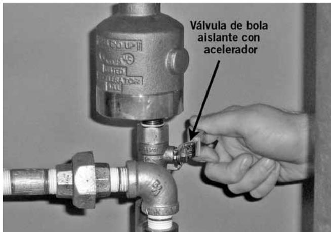
2. Si instala un acelerador seco Serie 746-LPA, cierre la válvula de bola aislante.
