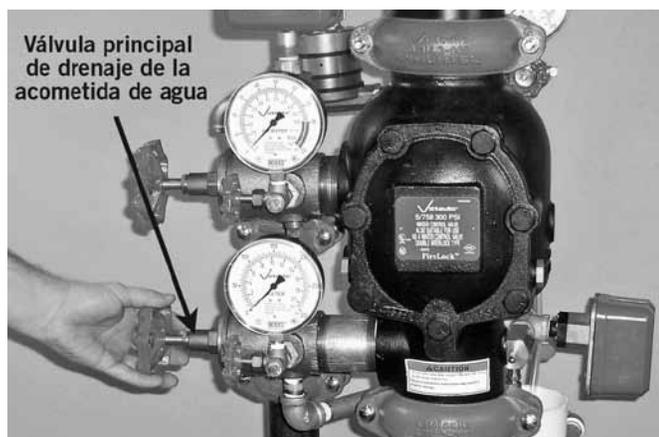
2. Abra completamente la válvula del drenaje principal de la acometida de agua para limpiar las tuberías de materiales contaminantes.
