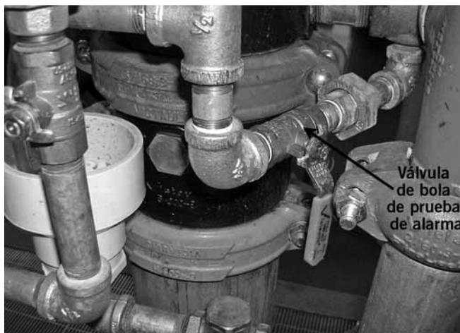
5. Cierre la válvula de bola de prueba de alarma después de verificar el correcto funcionamiento de todas las alarmas.
