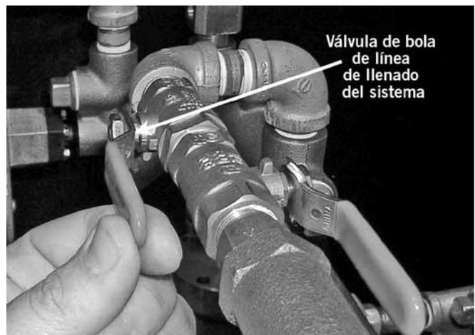
10. Ponga la válvula de bola en la línea de llenado del sistema en posición "ABIERTA - LLENADO RÁPIDO". Vuelva a poner la presión normal.
