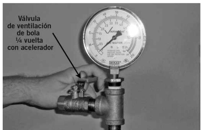
22. Si instala un acelerador seco LPA Serie 746, cierre la válvula de ventilación de bola 1/4 de vuelta.
