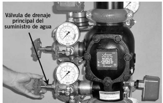
3. Abra completamente la válvula principal de drenaje del suministro de agua para eliminar a ras cualquier contaminante del suministro de agua.
