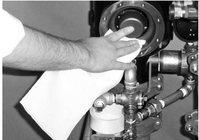
5. Limpie la parte posterior del cuerpo de la válvula para eliminar las impurezas que puedan intervenir con el asentamiento adecuado del diafragma.
