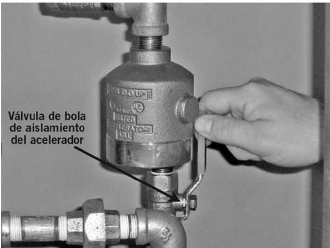
13. Si hay instalado un acelerador seco Serie 746-LPA, abra la válvula de bola de aislamiento.
