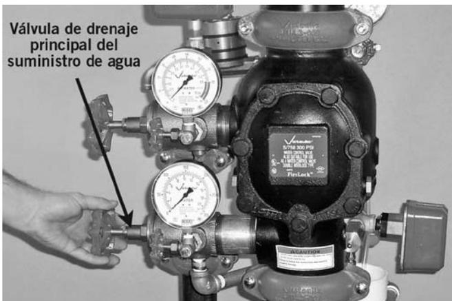
2. Abra completamente la válvula principal de drenaje del suministro de agua para eliminar cualquier contaminante del suministro de agua.
