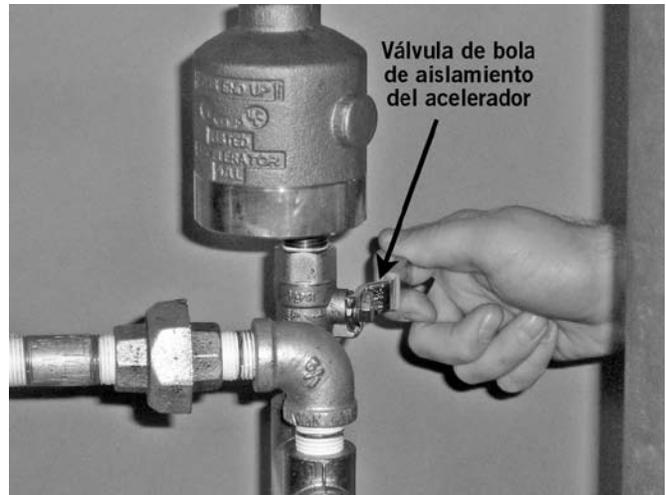
4. Si se instaló un acelerador seco Serie 746-LPA, confirme que la válvula de bola de aislamiento al acelerador esté cerrada.
