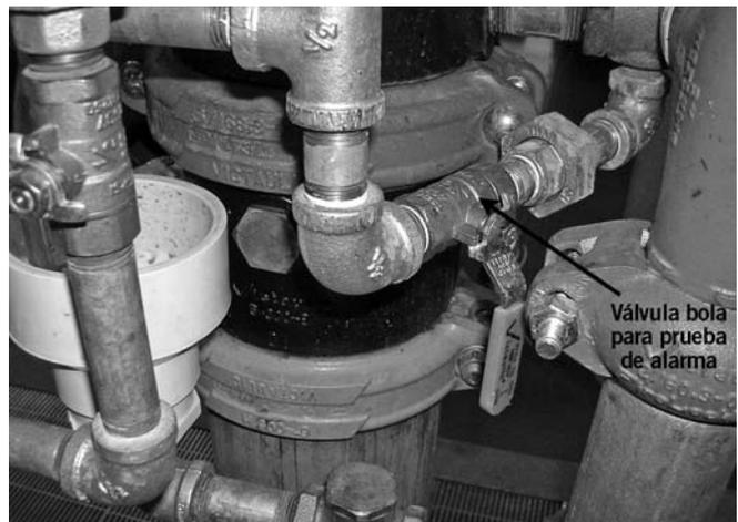
5. Cierre la válvula de bola para prueba de alarmas después de verificar el funcionamiento correcto de todas las alarmas.
