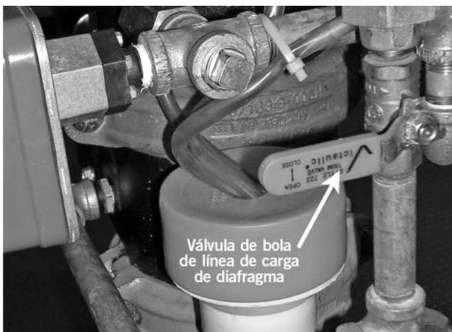
21. Cuando la línea de carga del diafragma esté presurizada, cierre temporalmente la válvula de bola de la línea de carga del diafragma. Confirme que se mantiene la presión en la línea de carga del diafragma observando el manómetro de presión de la línea de carga del diafragma.
