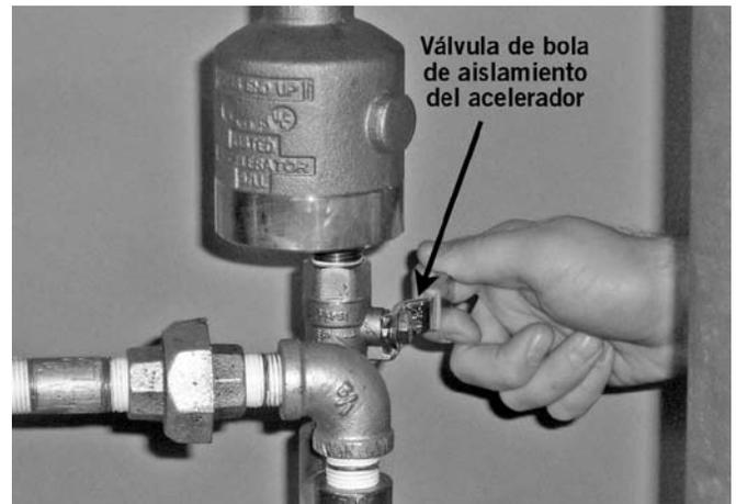
2. Si hay instalado un acelerador seco Serie 746-LPA, cierre la válvula de bola de aislamiento.
