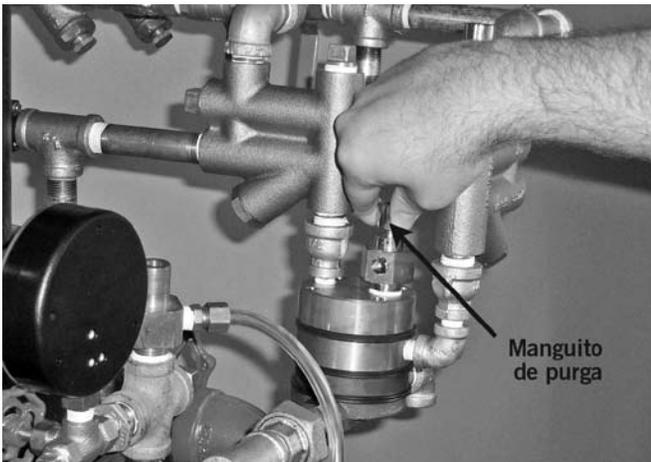
15. Cuando la presión llegue aproximadamente a 10 psi/69 kPa/0,7 bares y no se libere más humedad por el venteo automático, levante el manguito de purga de la cámara del sistema en el actuador neumático/neumático Serie 798. **NOTA:** El tornillo de purga de la cámara del sistema debería quedar sellado y permanecer en posición de ajuste ("ARRIBA").
