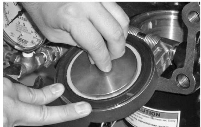
10. Coloque el anillo de retención de sello en la arandela del sello de la clapeta. Instale el montaje de sello del perno/sello del perno a través del anillo de retención del sello y la clapeta.
