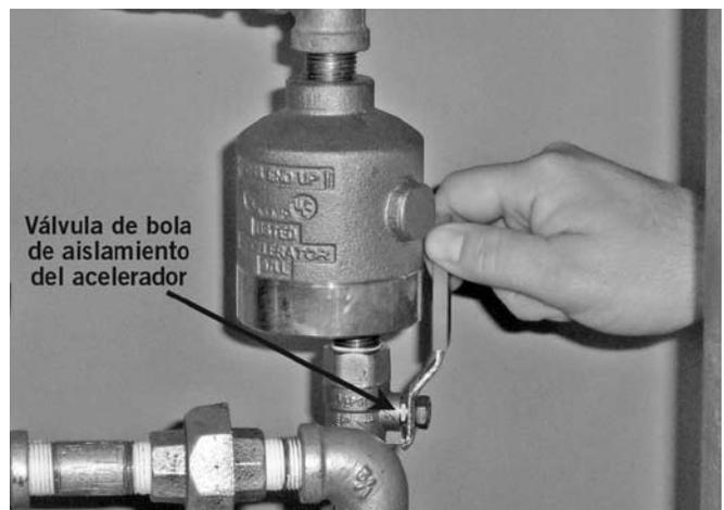
Válvula de bola de aislamiento del acelerador
