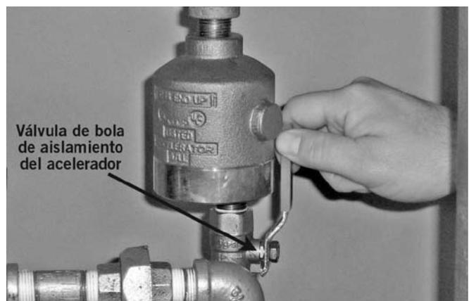
23. Si hay instalado un acelerador seco Serie 746-LPA, abra la válvula de bola de aislamiento. Esto ajustará el acelerador.
