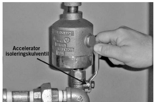
23. Om en serie 746-LPA accelerator är installerad, öppna isoleringskulventilen. Detta ställer in acceleratorn.
