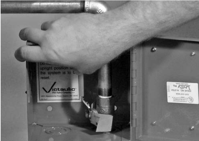
19. Stäng den manuella aktiveringsstationen.
