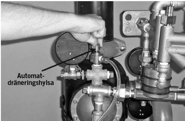
20. Dra upp automatdräneringshylsan tills skruven är i satt läge ("UPP"). Kontrollera att det finns tryck på manometern för membranladdningsledningen.
