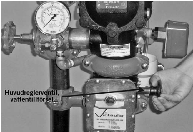
5. Stäng vattentillförselns huvudreglerventil.
