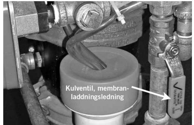
21b. Om trycket i membranladdningsledningen inte faller, öppna membran-laddningsledningens kulventil igen och gå vidare till nästa steg.
