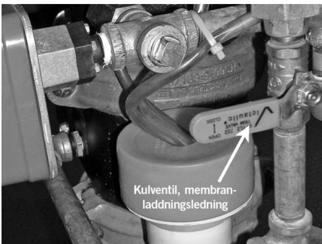
21. När membranladdningsledningen är trycksatt, stäng tillfälligtvis membran-laddningsledningens kulventil. Bekräfta att membran-laddningsledningen håller trycket genom att kontrollera på membran-laddningsledningens manometer.
