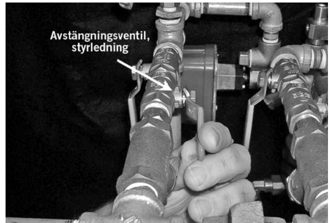
9. Stäng "avstängningsventilen" (gult handtag) på styrledningen.
