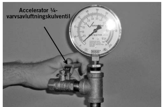
22. Om en serie 746-LPA accelerator är installerad, stäng 1/4-varvs avluftningskulventilen.
