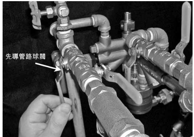
12. 達到13 psi/90 kPa/0.9 Bar的最低壓力後，請關閉先導充氣管路中的球閥，將其扳至“CLOSED - RESTRICTED FILL”（關閉-限制充氣）位置。
