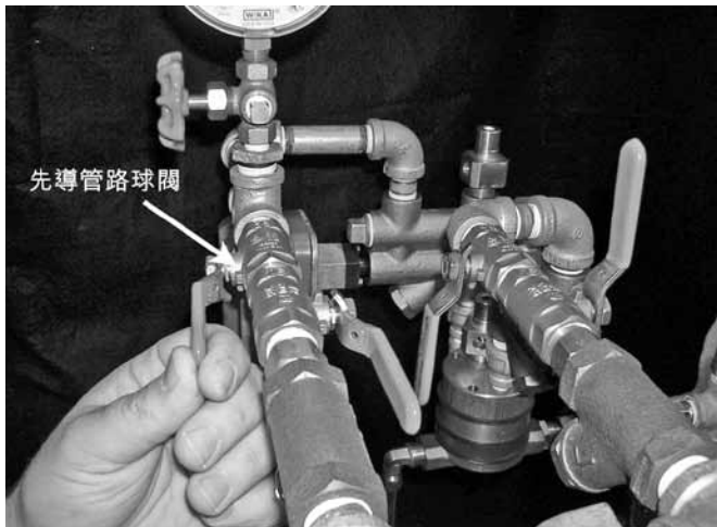
11. 打開先導充氣管路中的球閥，將其扳至“OPEN - FAST-FILL”（開啟-快充）位置。讓壓力重新升至正常壓力。
