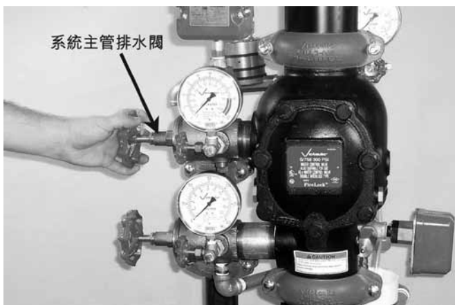
6. 緩慢部分開啟系統主管排水閥。確認水沒有從排水管流出。 說明：如果水從排水管流出，則系統可能還沒有正確排乾積水。 在這種情況下，請遵照執行“讓系統投入運行”一節中的所有步驟。 7. 記錄低氣壓警報器啟動時的系統氣壓。
