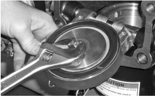
要求的密封裝配螺栓/螺栓密封墊扭矩
