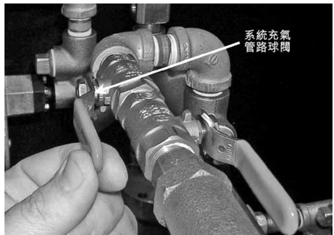
10. 打開系統充氣管路中的球閥，將其扳至“OPEN — FAST-FILL(開啟—快充)”位置。讓壓力重新回到正常系統壓力。
