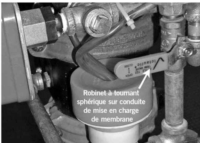
22. Lorsque la conduite de mise en charge de la membrane est sous pression, fermer temporairement le robinet à tournant sphérique sur cette conduite. Vérifier que la pression se maintient dans la conduite de mise en charge de la membrane au moyen du manomètre sur cette conduite.
