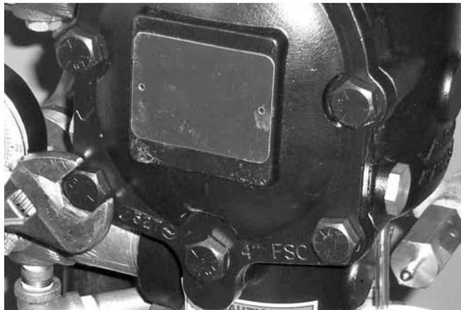
4. Mettre en place l'ensemble plaque-couvercle/joint de plaque-couvercle sur le clapet. S'assurer que les pattes du ressort de disque ont été tournées à leur position d'installation. Serrer les boulons de la plaque-couvercle dans la plaque-couvercle/le corps du clapet.
