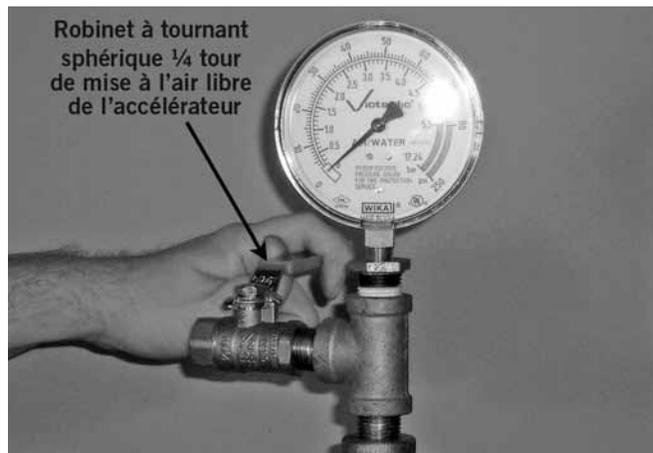
23. **SYSTÈMES INSTALLÉS AVEC ACCÉLÉRATEUR SOUS AIR SÉRIE 746-LPA** : fermer le robinet à tournant sphérique ¼ de tour l'accélérateur.
