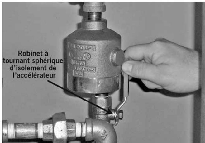
24. **SYSTÈMES INSTALLÉS AVEC ACCÉLÉRATEUR SOUS AIR SÉRIE 746-LPA** : ouvrir le robinet à tournant sphérique d'isolement. L'accélérateur est alors prêt à fonctionner.
