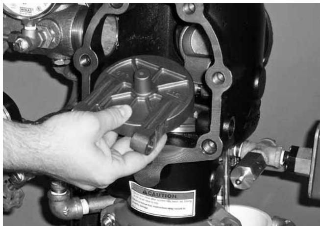
4. Retirer le disque du corps du clapet.
