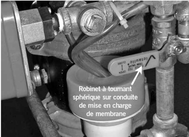
7. Fermer le robinet à tournant sphérique sur conduite de mise en charge de membrane.
