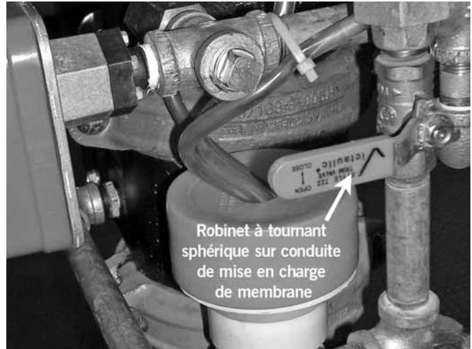
12. Fermer le robinet à tournant sphérique sur conduite de mise en charge de membrane.
