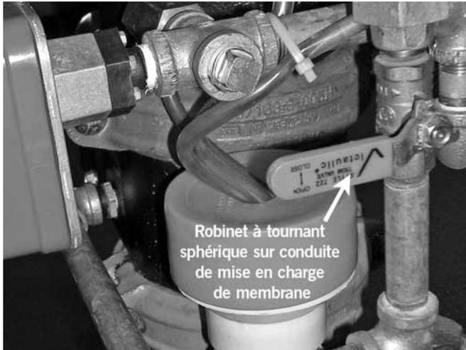
10. Fermer le robinet à tournant sphérique sur conduite de mise en charge de membrane.
