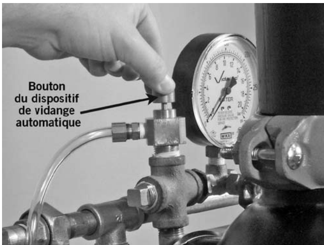
21. Tirez vers le haut le bouton du dispositif de vidange automatique jusqu'à ce que la vis soit en position «marche» (haute). Vérifiez qu'il y a de la pression sur le manomètre de la conduite de pressurisation du diaphragme.
