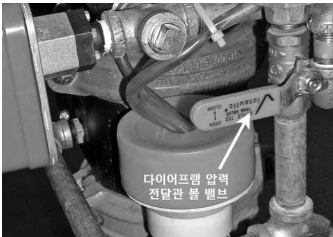
22. 다이어프램 압력전달관이 압력을 받고 있을 때, 다이어프램 압력전달관의 볼 밸브를 일시적으로 닫아 주십시오. 다이어프램 압력전달관의 압력 게이지를 살펴 다이어프램 압력전달관의 압력이 유지되고 있는지 확인해 주십시오.
