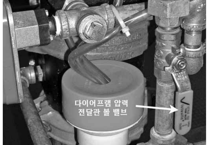
22b. 다이어프램 압력전달관의 압력이 떨어지지 않으면, 다이어프램 압력전달관의 볼 밸브를 다시 열고 다음의 과정을 따르십시오.
