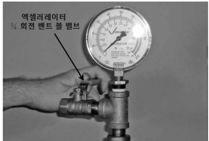
23. Series 746-LPA 견식 엑셀레이터가 설치되어 있는 시스템: 엑셀러레이터의 1/4-회전 볼 밸브를 닫으십시오.
