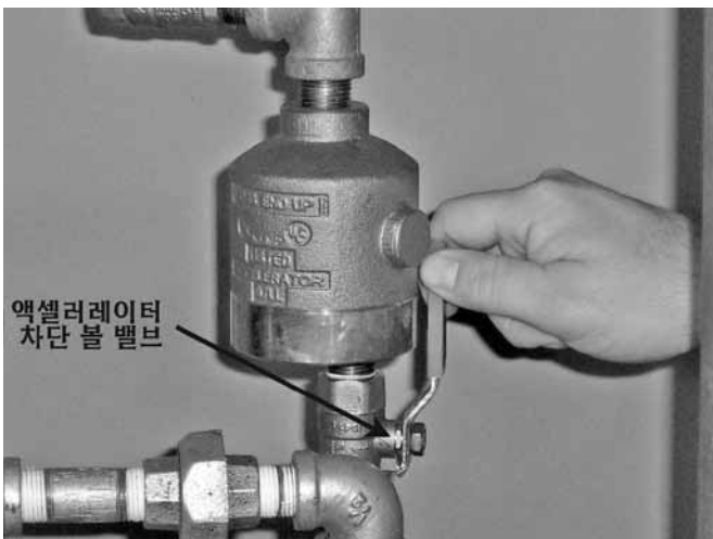
13. Series 746-LPA 드라이 엑셀레이터가 설치되면, 절연 불 밸브를 여십시오.
