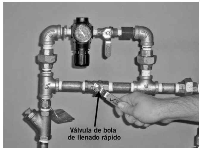
10. Abra la válvula de bola de llenado rápido en el AMTA. Vuelva a poner la presión normal del sistema.
