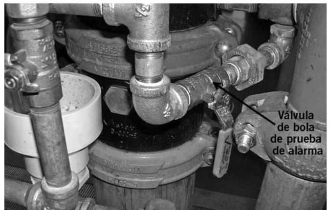
10. Confirme que la válvula de bola de prueba de alarma está cerrada.
