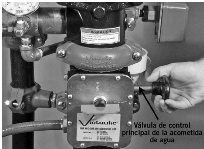
5. Cierre la válvula de control principal de la acometida de agua.
