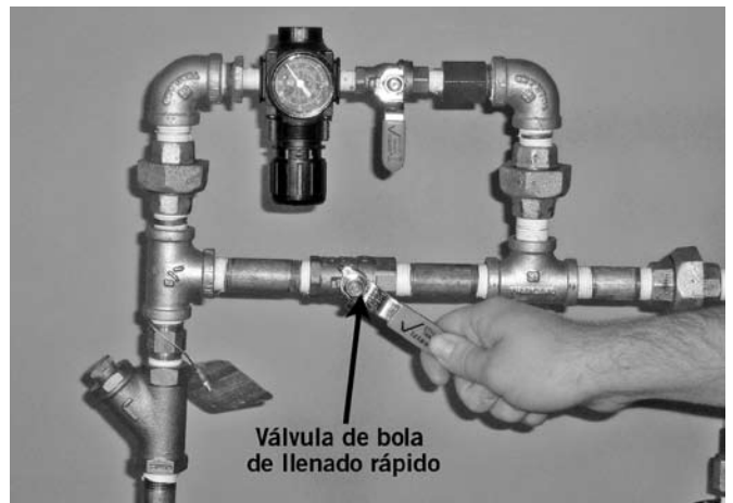
10. Confirme que la válvula de bola de prueba de alarma está cerrada.
