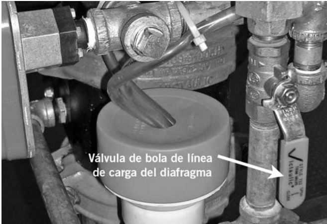
5. Abra la válvula de bola de línea de carga del diafragma.
