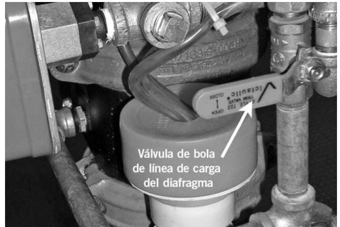
9. Cierre la válvula de bola de línea de carga del diafragma.
