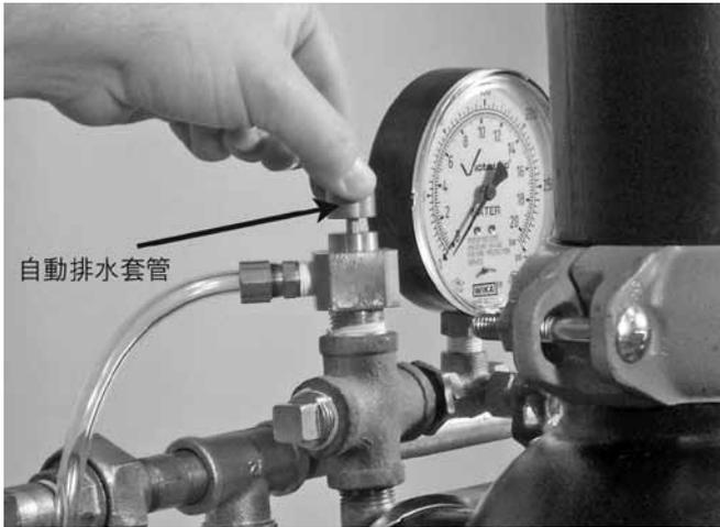
21. 提起自動排水套管至螺釘處於就位（“升起”）位置。確認隔膜注水管路上的壓力錶顯示有壓力。
