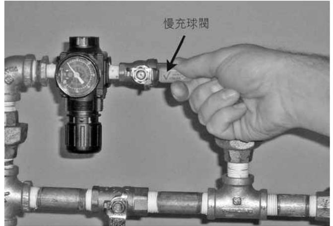
17. 打開AMTA上的慢充球閥。說明：慢充球閥未打開會導致系統壓力下降，從而使閥門在工作時發生系統洩漏。
