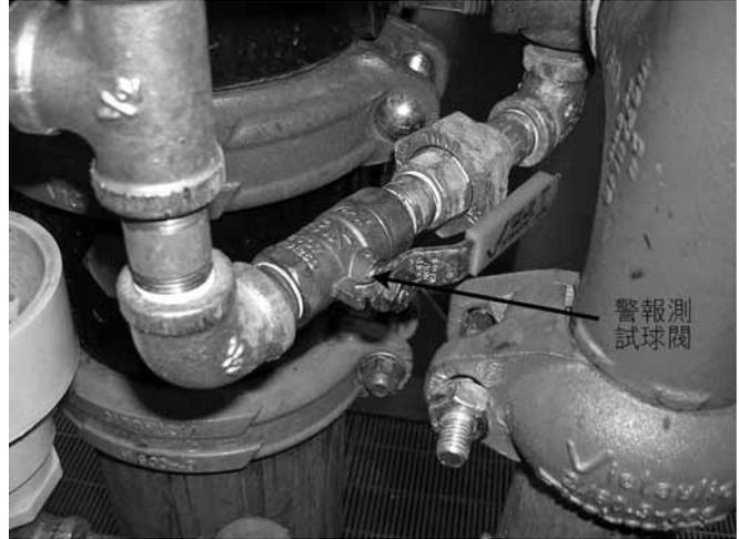
4. 打開警報測試球閥。確認已啟動機械與電氣警報器，且遠程監控站(如果配備的話)接收到一個警報信號。
