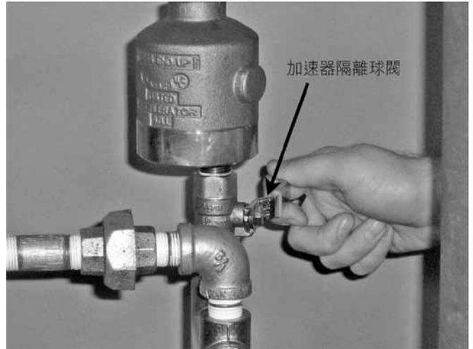
4. 對於安裝了746-LPA系列乾式加速器的系統：請確認至加速器的隔離球閥已關閉。
