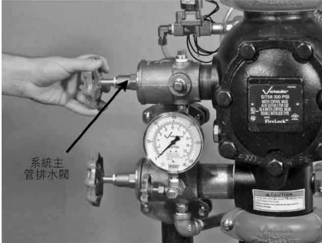
10. 關閉系統遠程測試閥（檢查員測試連接）或系統主管排水閥。說明：系統主管排水閥如上圖所示。
