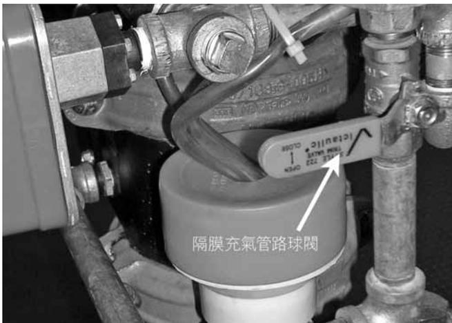
22. 當隔膜注水管路壓力建立起來後，暫時關閉隔膜注水管路球閥。通過觀察隔膜注水管路壓力錶讀數，確認隔膜注水管路壓力維持不變。
