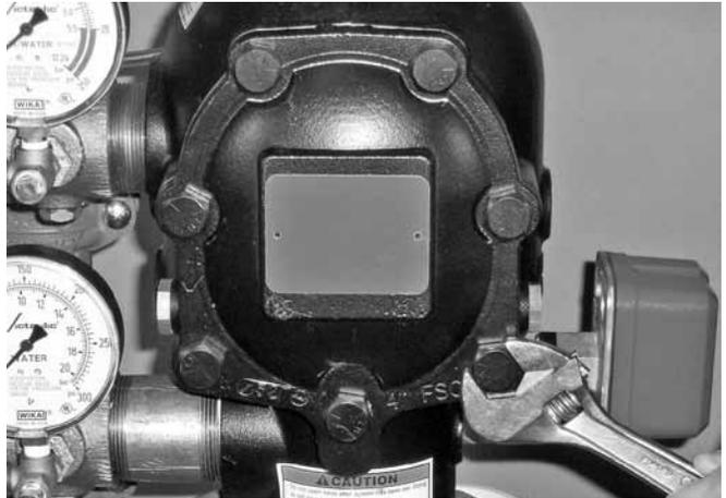
11. 在釋放完系統內的全部壓力後，緩慢鬆開閥蓋螺栓。說明：在鬆開全部閥蓋螺栓之前，切勿拆除任何閥蓋螺栓。
