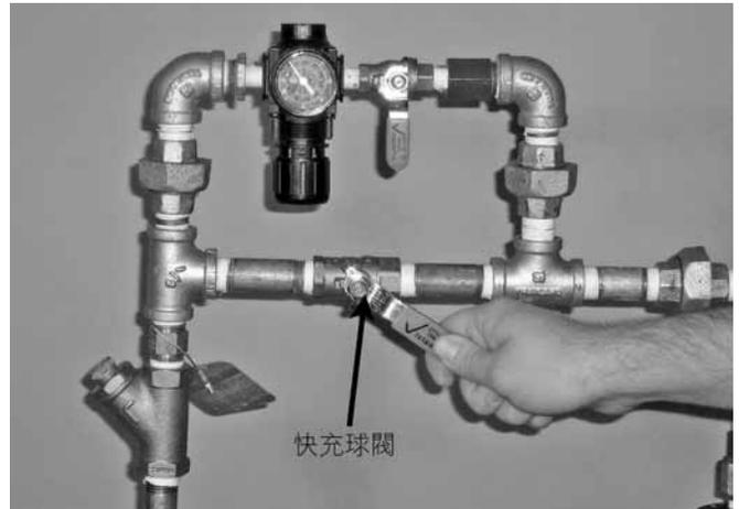
11. 啟動壓縮機或打開AMTA上的快充球閥（快充球閥如上圖所示），給系統充氣。系統充氣壓力最低13 psi/90 kPa/0.9 Bar。請參閱“供氣要求”一節。
