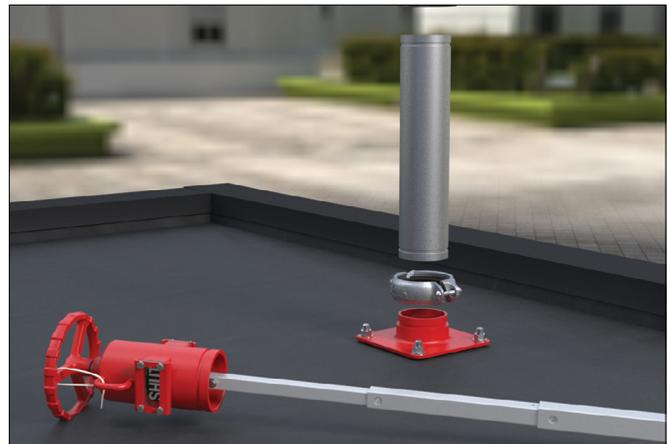
10. Befestigen Sie die Rohrverlängerung mit der Kupplung aus dem Satz an der Halterung. Befolgen Sie immer die maßgebliche Kupplungs-Montageanleitung im Montagehandbuch I-100, das von victaulic.com heruntergeladen werden kann.
