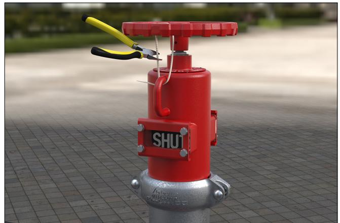
15. Vergewissern Sie sich, dass die mit „SHUT“ markierte Fläche sichtbar/im Fenster zentriert ist. Schneiden Sie das Spannbänder zwischen Handrad und Gehäuse durch und entfernen Sie es.
