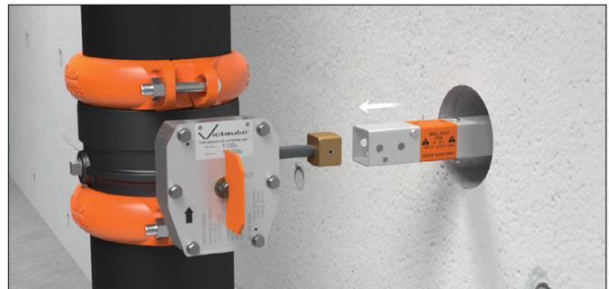
4. Führen Sie das Verlängerungsrohr in die Durchgangsbohrung zur Antriebsmutter.
