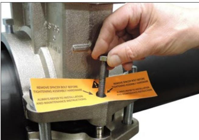
**5c. RETIRER UNIQUEMENT LES BOULONS D'ESPACEMENT :** un boulon d'espacement est présent sur chaque patin pour maintenir l'espacement entre les patins pendant l'expédition et le montage. Après avoir inséré le tube, retirer uniquement les boulons d'espacement et les étiquettes d'avertissement attachées avant de serrer les quatre écrous à l'étape 6.
