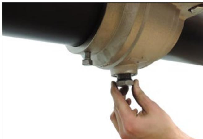
**3. RETIRER LE FOND :** à l'aide d'une clé de  $1\frac{1}{4}$ "/32 mm (pour les vannes 3 à 8") ou d'une clé de  $1\frac{1}{2}$ "/38 mm (pour les vannes de 10 à 12"), retirer le fond situé au bas du corps de la vanne.
