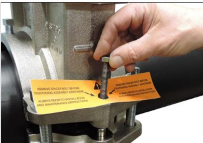
**5c. REMOVER SOMENTE OS PARAFUSOS DE ESPAÇAMENTO:** Há um parafuso de espaçamento em cada apoio de parafuso para manter o espaçamento entre os apoios de parafuso durante o transporte e a montagem. Após inserir o tubo, remover somente os parafusos de espaçamento e os rótulos de advertência anexados antes de apertar as quatro porcas na etapa 6.
