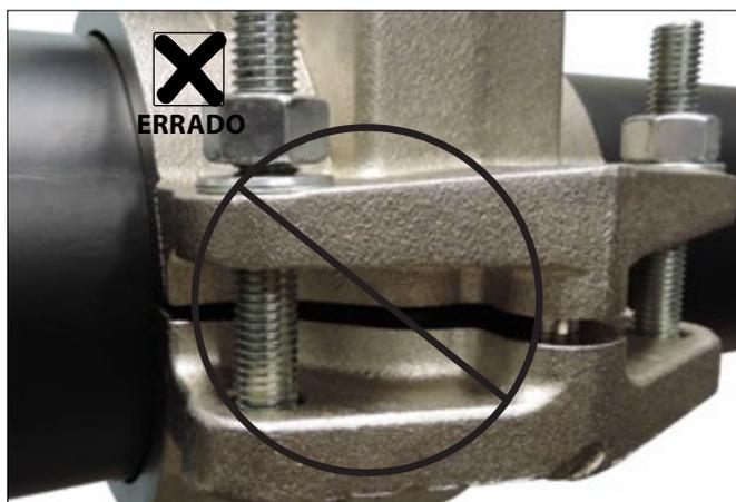
**7. INSPECIONAR APOIOS:** Inspeção visualmente os apoios de parafusos de cada conexão para verificar se houve contato metal-metal em toda a seção do apoio de parafuso.
