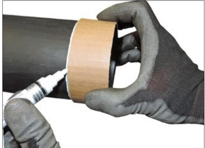
**4. MARCAR O TUBO:** Utilizando a luva de papelão e um lápis de pintura, marque cada extremidade de tubo PEAD ao redor da circunferência completa:
