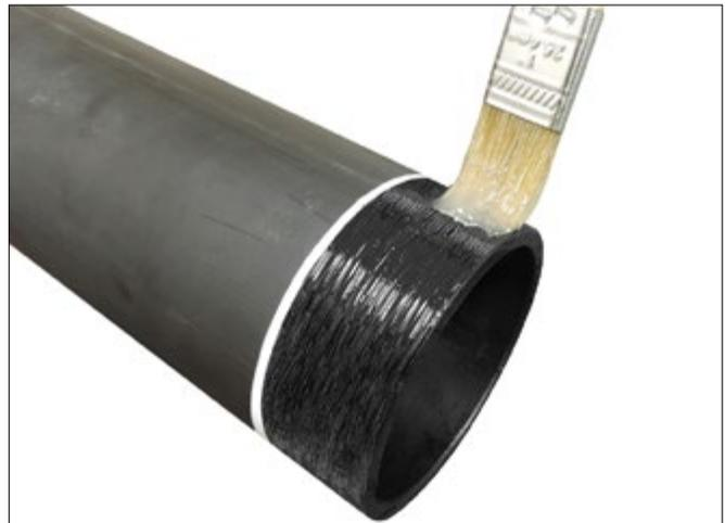
**5. LUBRIFICAR AS EXTREMIDADES DO TUBO:** Aplique uma fina camada de lubrificante na extremidade do tubo a partir da extremidade do tubo até a marca pintada feita na etapa 4.
