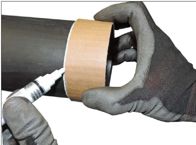
**4. MARQUE LA TUBERÍA:** Usando la manga de cartón y una barra de pintura, coloque una marca en cada extremo de la tubería de HDPE alrededor de su circunferencia:
