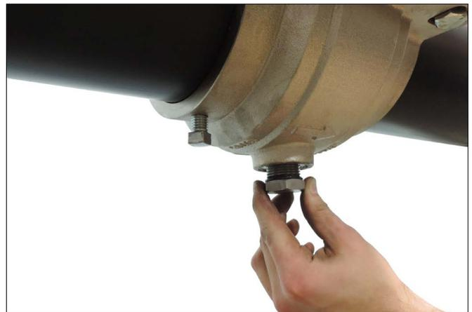
3. **QUITE EL TAPÓN:** Usando una llave de  $\frac{1}{4}$  pulg./32 mm (para válvulas de 3 a 8") o una llave de  $\frac{1}{2}$  pulg./38 mm (para válvulas de 10 a 12"), quite el tapón de la parte inferior del cuerpo de la válvula.
