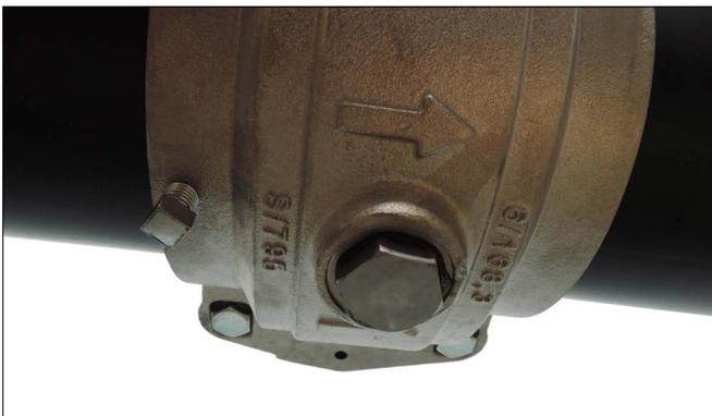
**7. REINSTALE EL TAPÓN:** Reinstale el tapón en la parte inferior del cuerpo de la válvula, y apriételo como se indica en la tabla siguiente.
