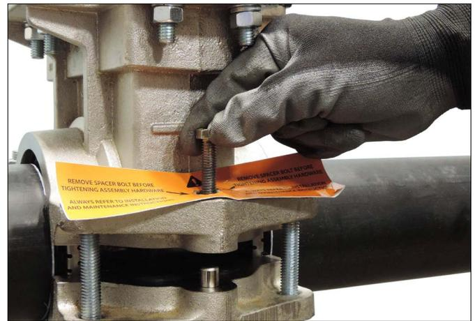
**5c. RETIRE ÚNICAMENTE LOS PERNOS ESPACIADORES:** Hay un perno espaciador en cada cierre emperrado para mantener la distancia en el cierre durante el despacho y el montaje. Después de insertar la tubería, retire únicamente los pernos espaciadores y las etiquetas de advertencia antes de apretar las cuatro tuercas según indica el paso 6.
