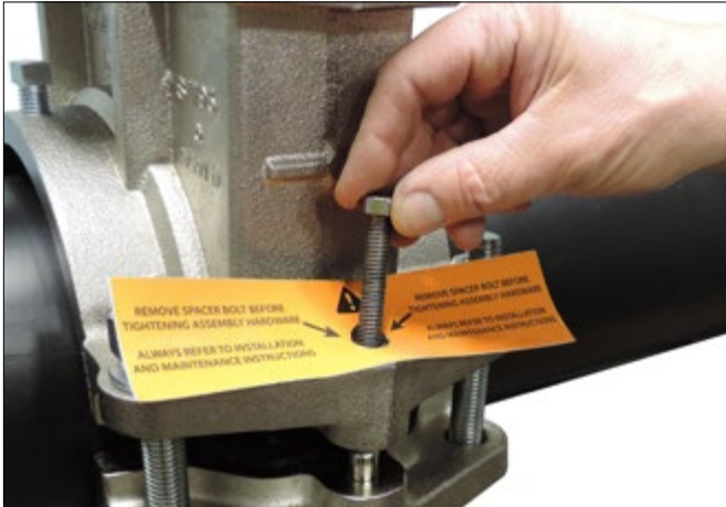
5c. SADECE ARA PARÇA CIVATALARINI SÖKÜN: Her bir civata yolunda nakliye ve montaj sırasında civata yolları arasındaki mesafenin korunması için bir ara parça civatası vardır. Boruyu monte ettikten sonra 6. adımda dört adet somunu sıkmaya başlamadan önce sadece ara parça civatalarını ve ilgili uyarı etiketlerini sökün.
